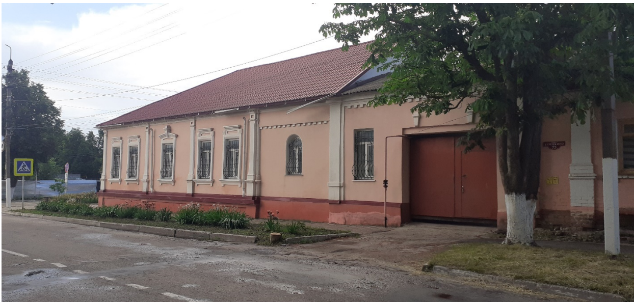
Фотография № 3. Вид с юго-запада на Объект.
