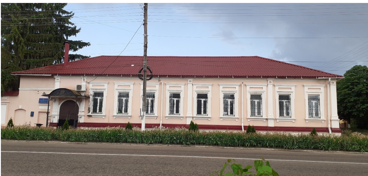
Фотография № 8. Вид с севера на Объект.
