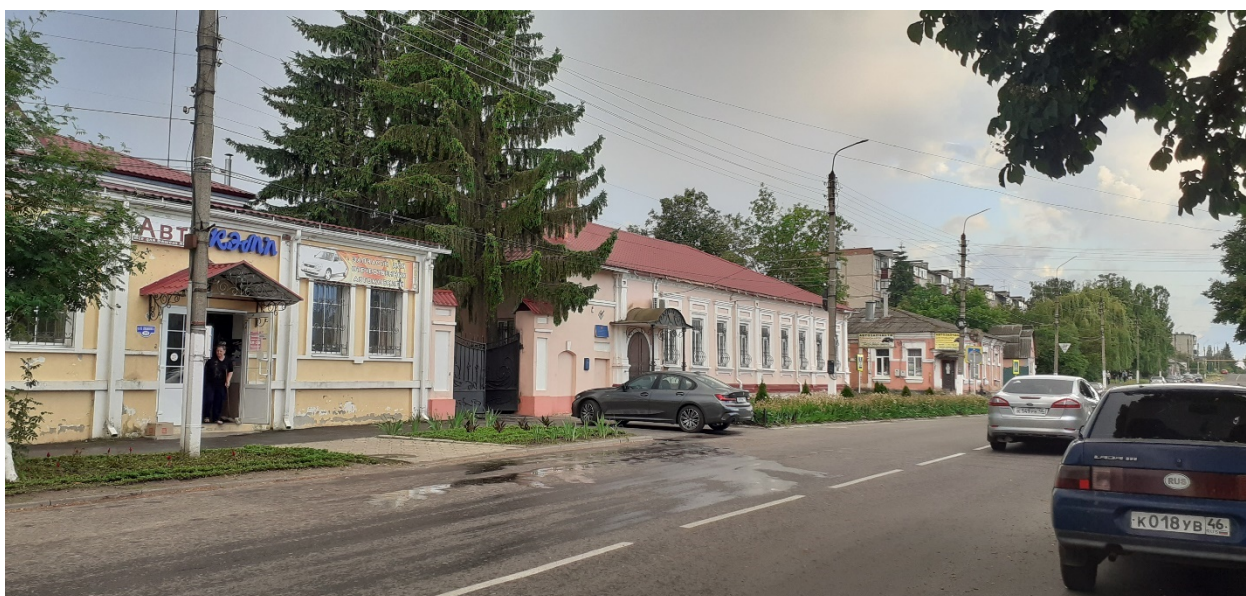
Фотография № 10. Вид с северо-востока на Объект.
