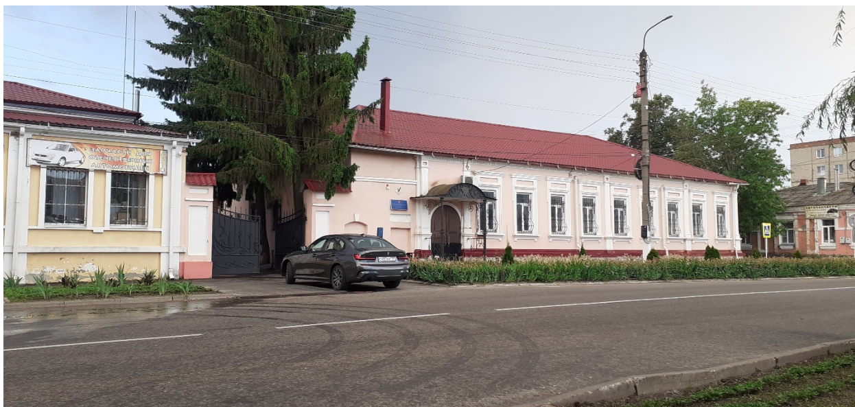
Фотография № 9. Вид с северо-востока на Объект.
