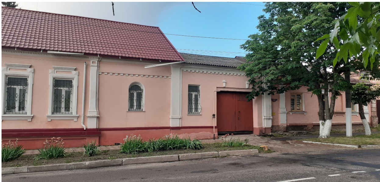
Фотография Объекта. Вид с северо-запада на Объект. Справа вплотную к Объекту примыкает выявленный объект культурного наследия «Дом жилой», кон. XIX - нач. XX вв., Курская область, г. Рыльск, ул. Урицкого, д. 73. Автор: Е.М. Федосеева
