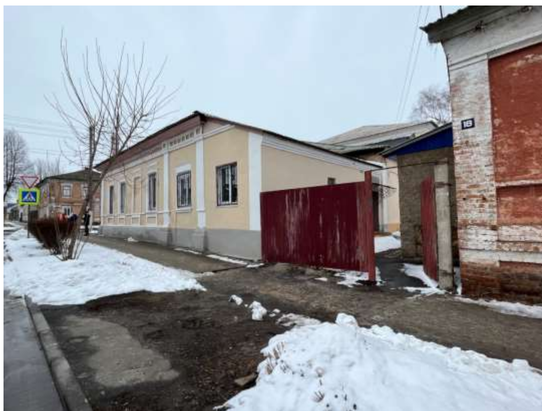
Фотография № 2. Вид с юго-востока на Объект.
