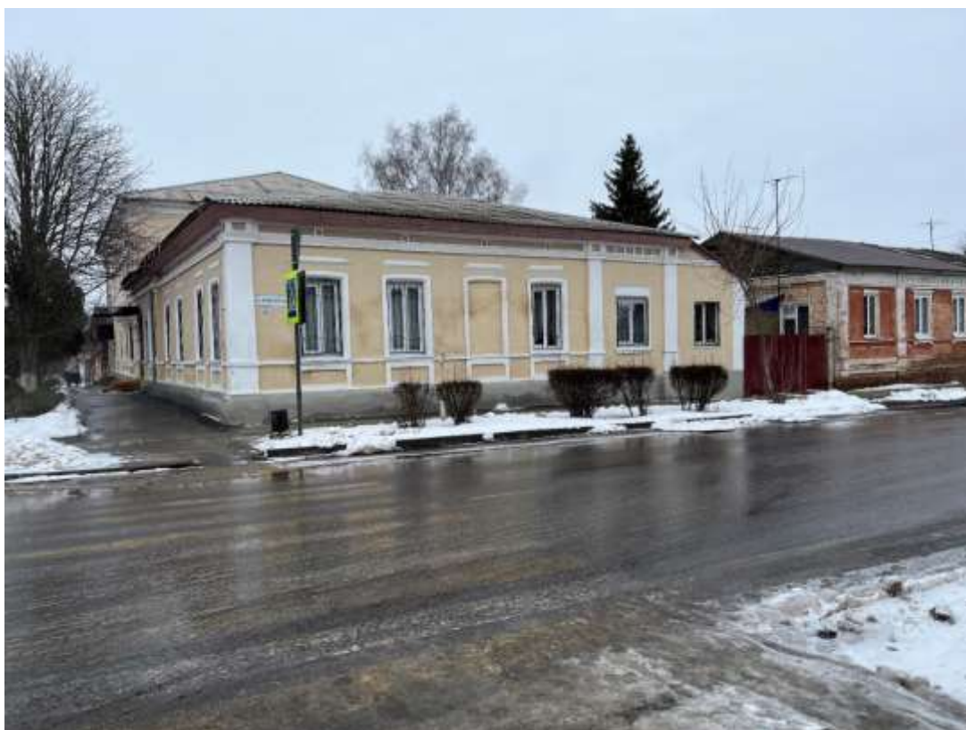
Фотография № 6. Вид с юго-запада на Объект.
