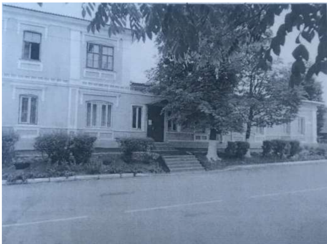
Объект культурного наследия регионального значения «Административное здание», начало XX в., Курская область, г. Рыльск, ул. Урицкого, д. 81. Фотофиксация из акта натурального визуального обследования и фотофиксация от 21.08.2019 № 89
