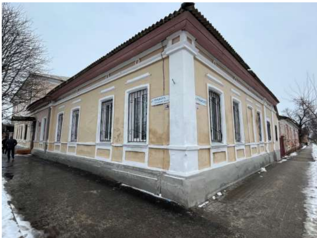
Фотография № 7. Вид с юго-запада на Объект.
