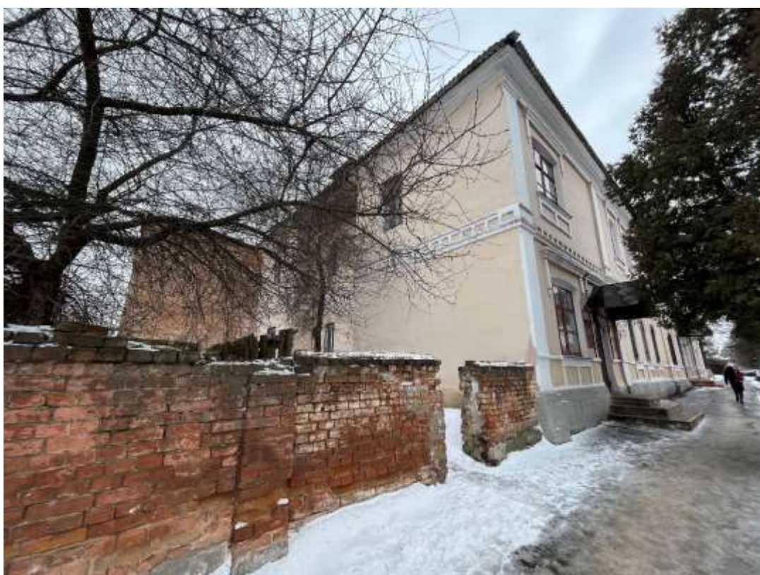
Фотография № 10. Вид северо-запада на Объект.
