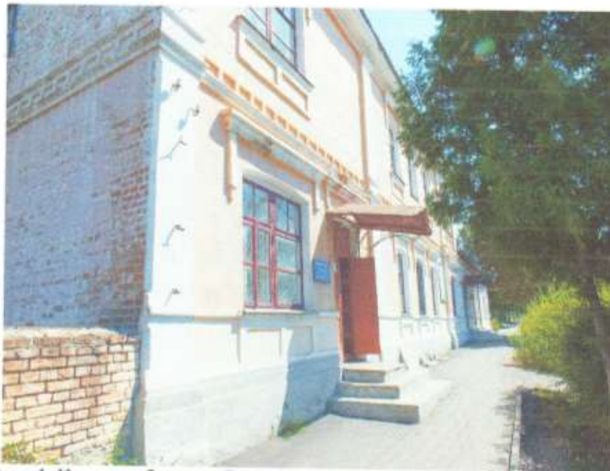
Фото 1. Курская область г. Рыльск, ул. Урицкого, 81. «Административное здание нач. XX в.»
