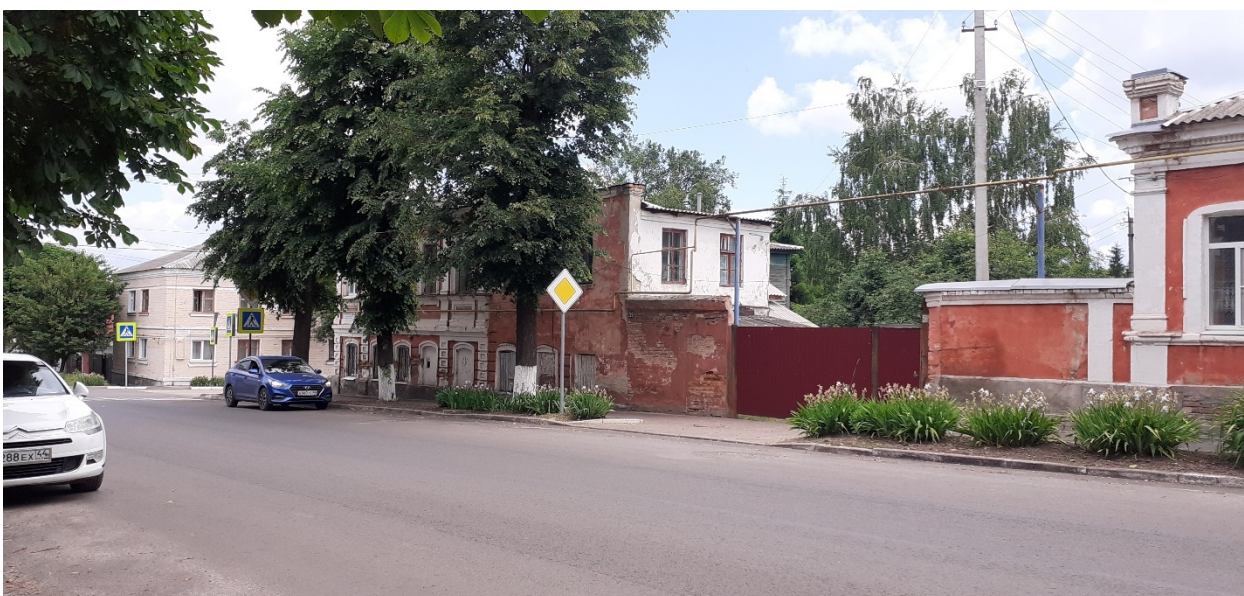
Фотография № 10. Вид с юго-запада на Объект.
