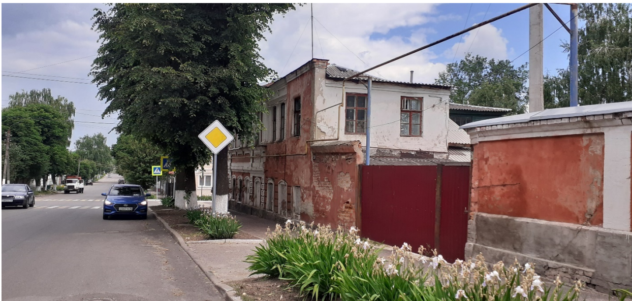
Фотография № 9. Вид с юго-запада на Объект.
