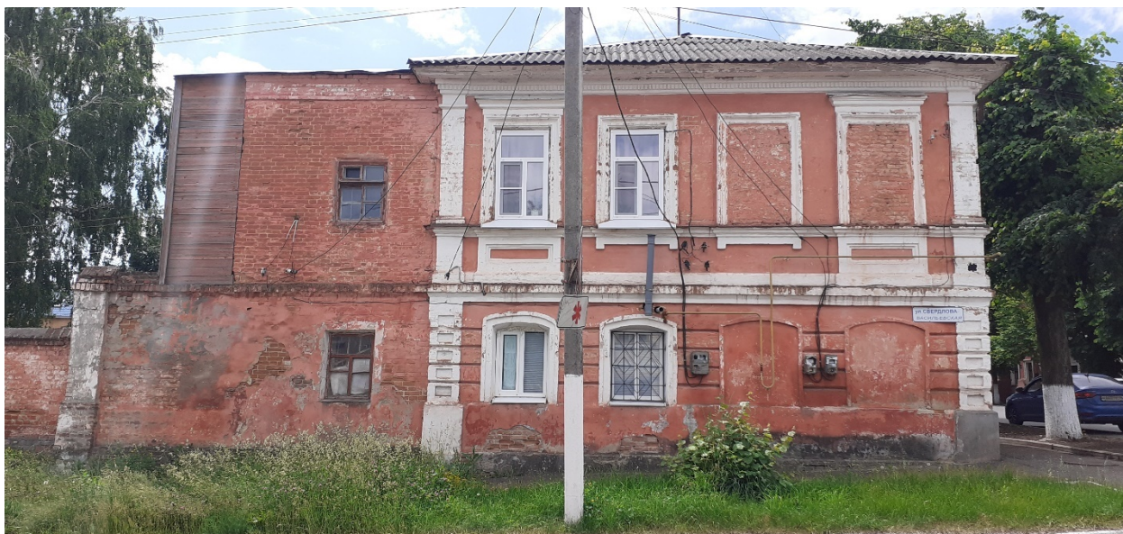
Фотография № 3. Вид с севера на Объект.
