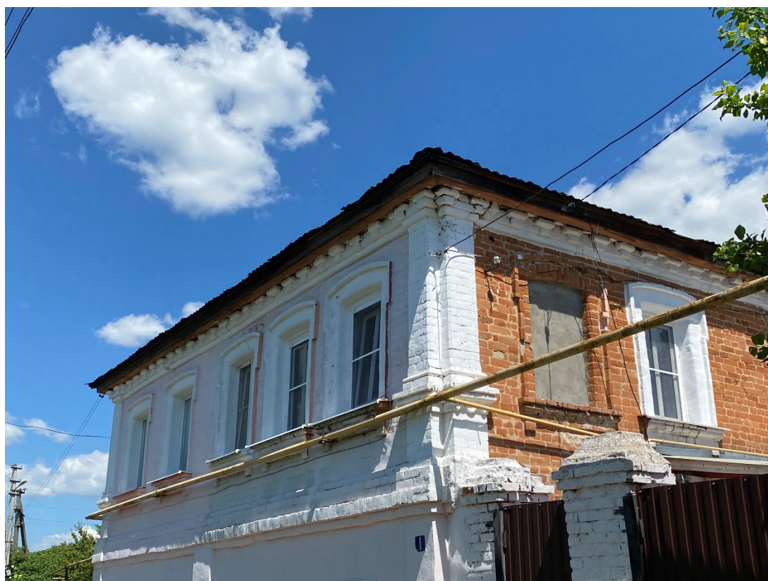
Фотография № 10. Вид с юго-запада на Объект. Угол западного и южного фасадов. Второй этаж.
