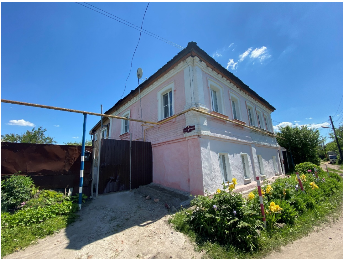
Фотография № 3. Вид с северо-запада на Объект.
