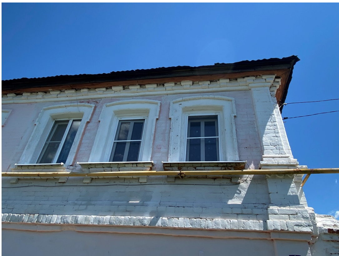
Фотография № 9. Вид с запада на Объект. Центральный (западный) фасад. Фрагмент.
