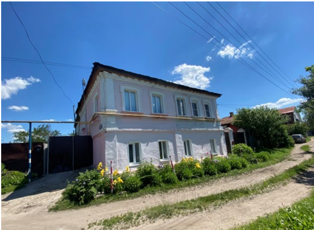
Фотография № 4. Вид с северо-запада на Объект.
