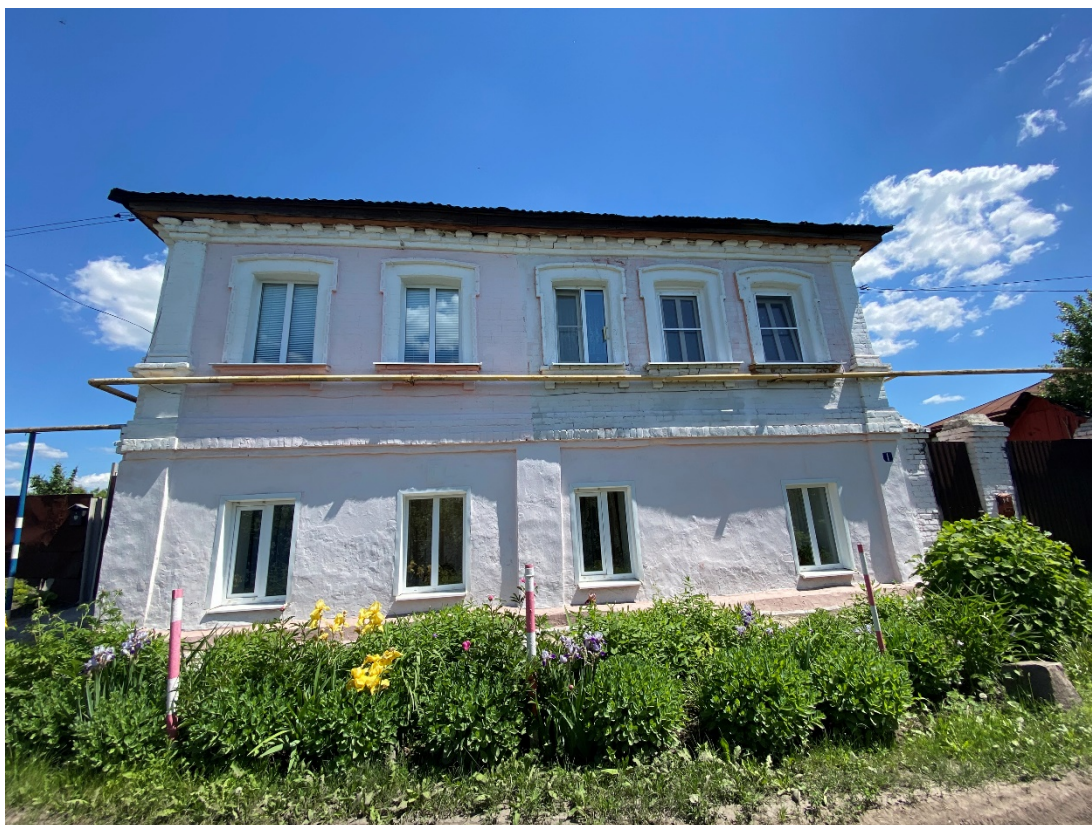
Фотография № 5. Вид с запада на Объект.
