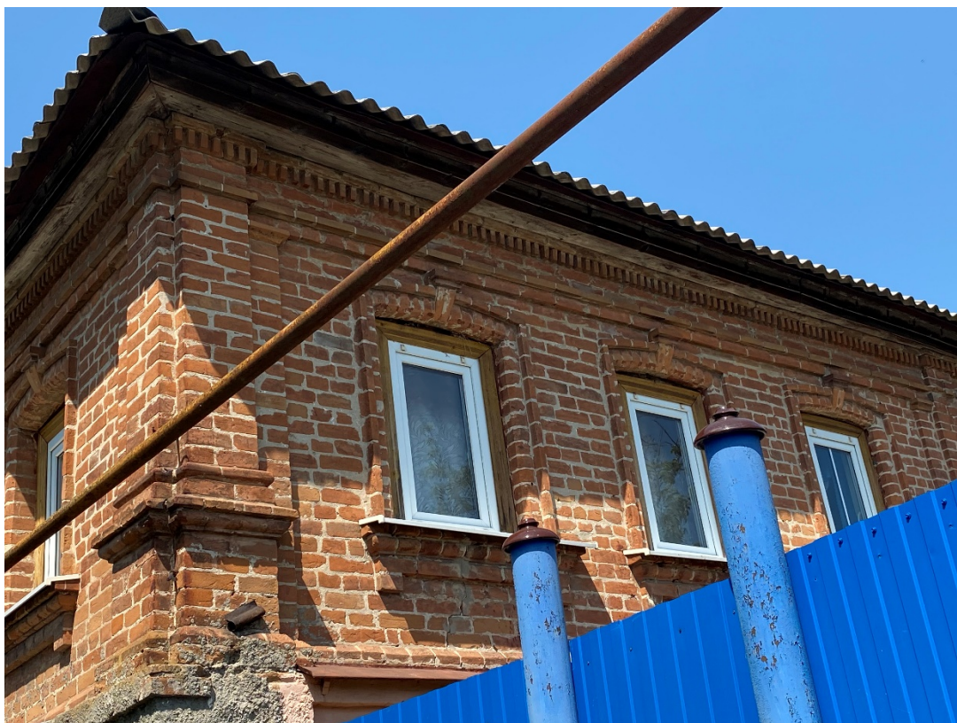
Фотография № 11. Вид с юго-востока на Объект. Восточный фасад. Фрагмент.
