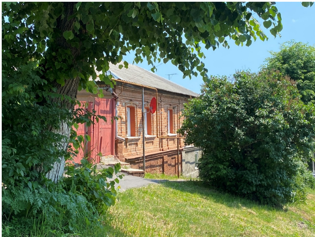
Фотография № 3. Вид с юго-запада на Объект.
