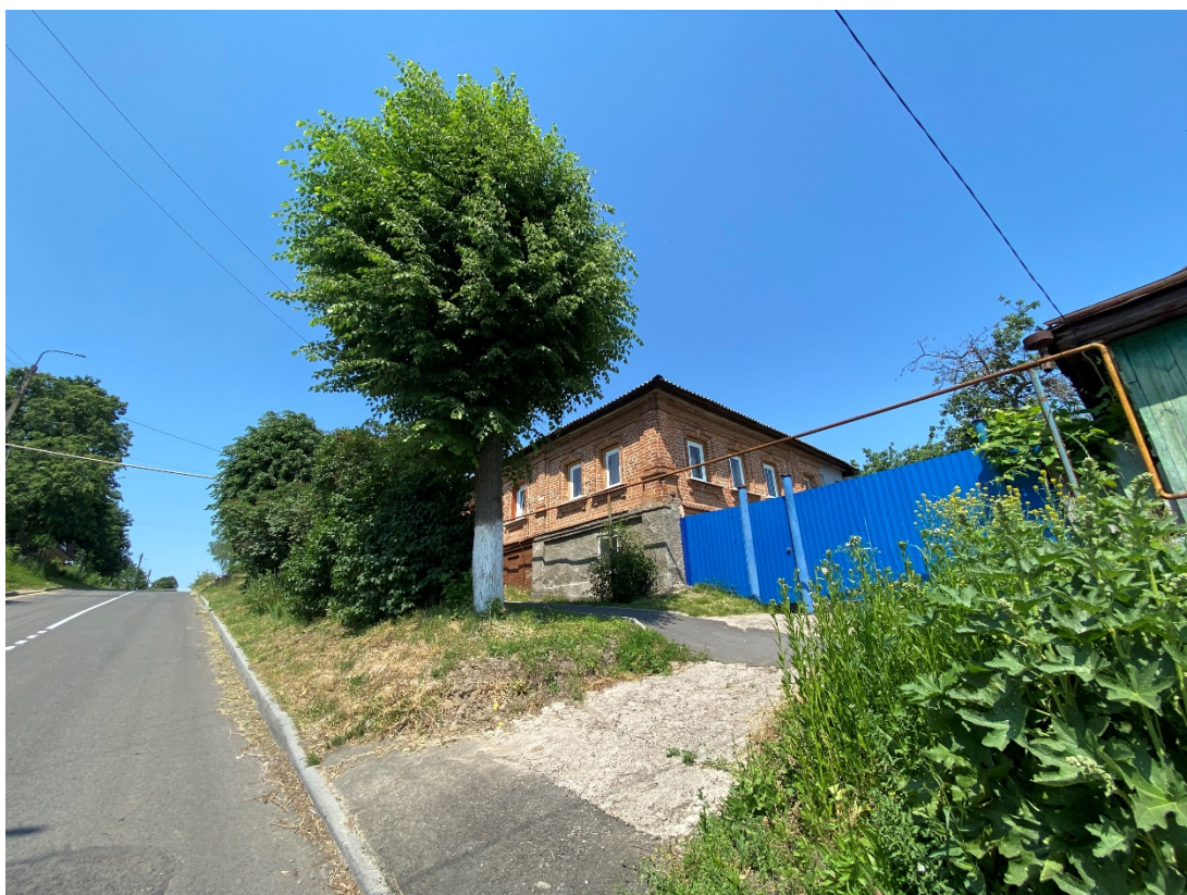
Фотография № 10. Вид с юго-востока на Объект.
