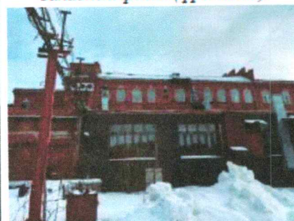
Западный фасад (фрагмент)
