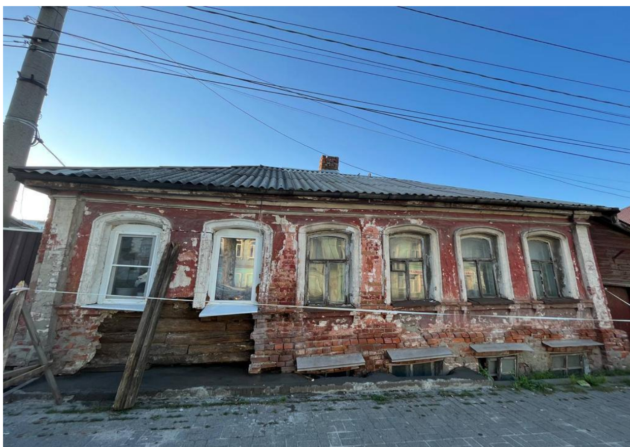
Фотография № 5. Вид с юго-запада на территорию расположения Объекта
