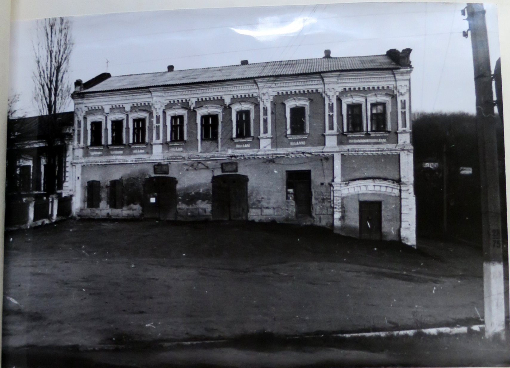
Строение, примыкающее к медучилищу справа. Ул. Совет- ская площадь.
