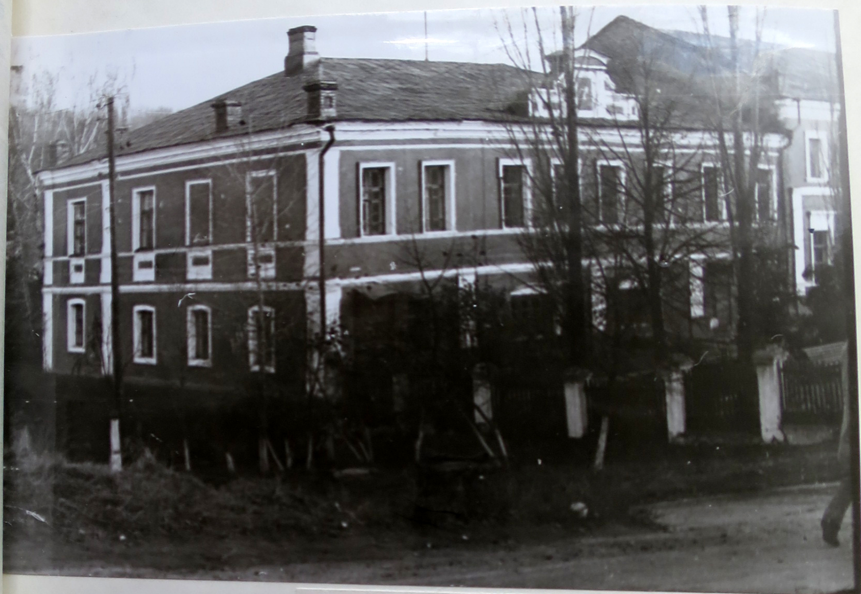
Общий вид строений.
