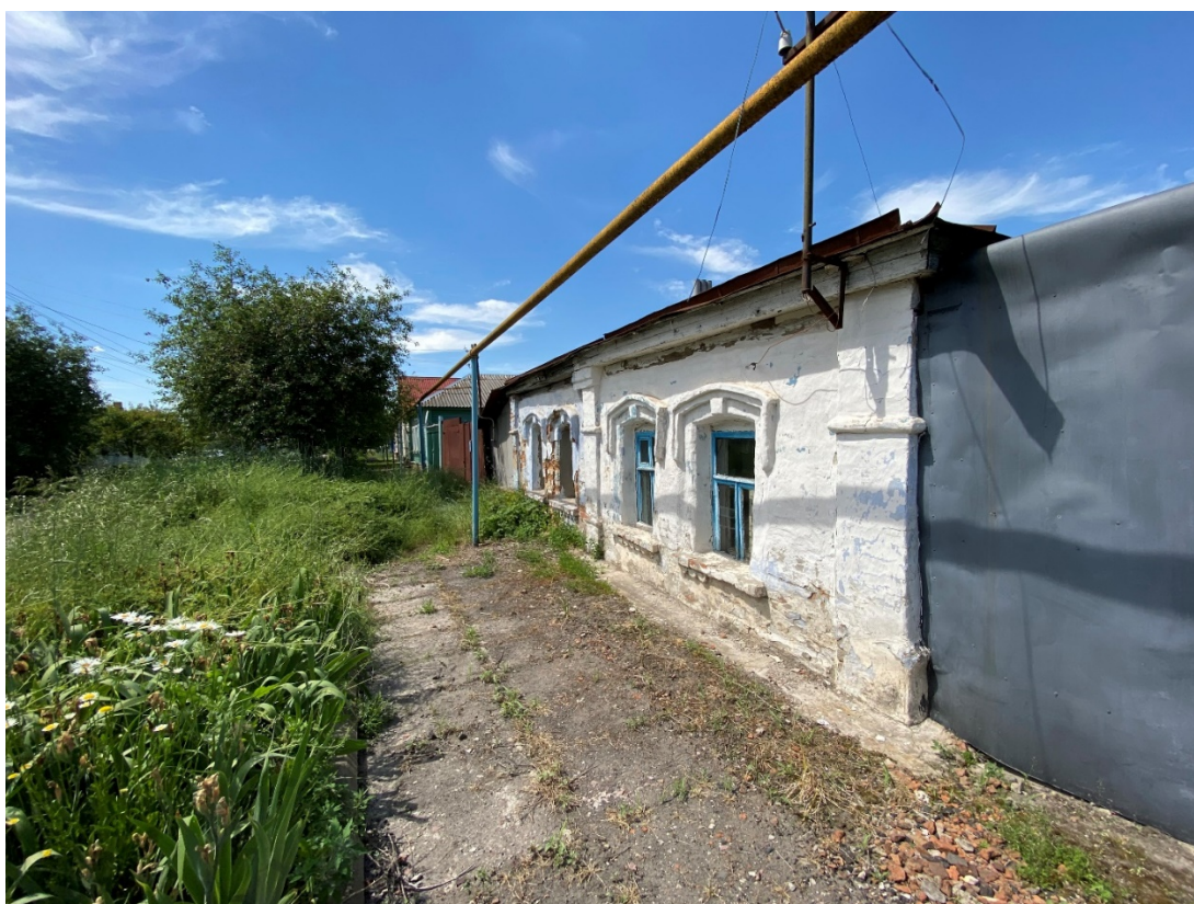
Фотография № 4. Вид с востока на Объект.
