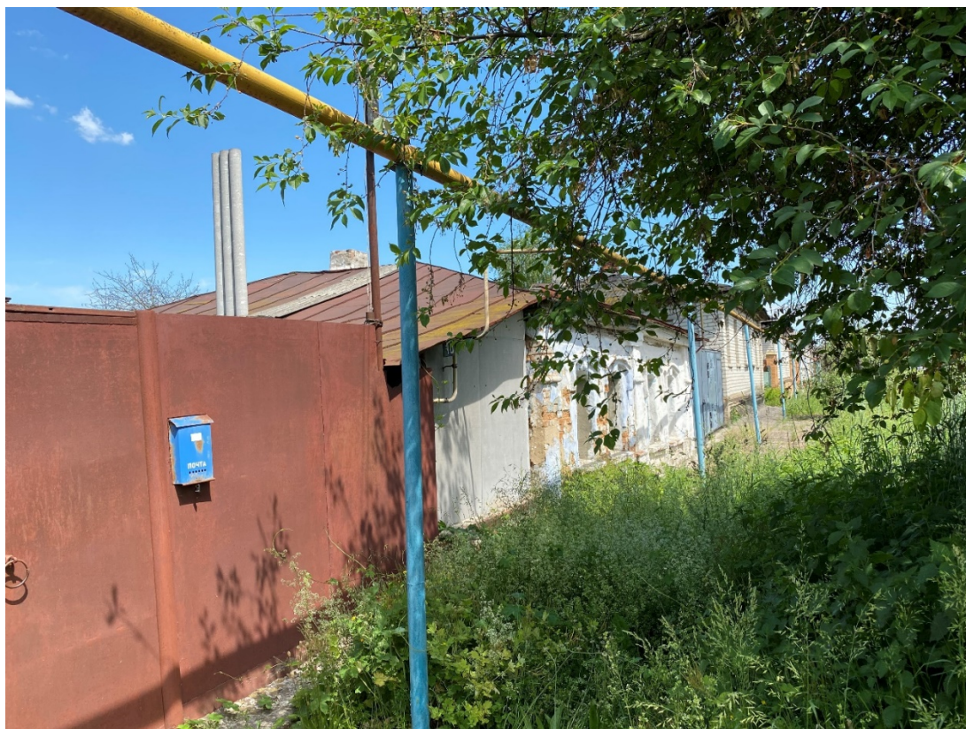
Фотография № 7. Вид с юго-запада на Объект.
