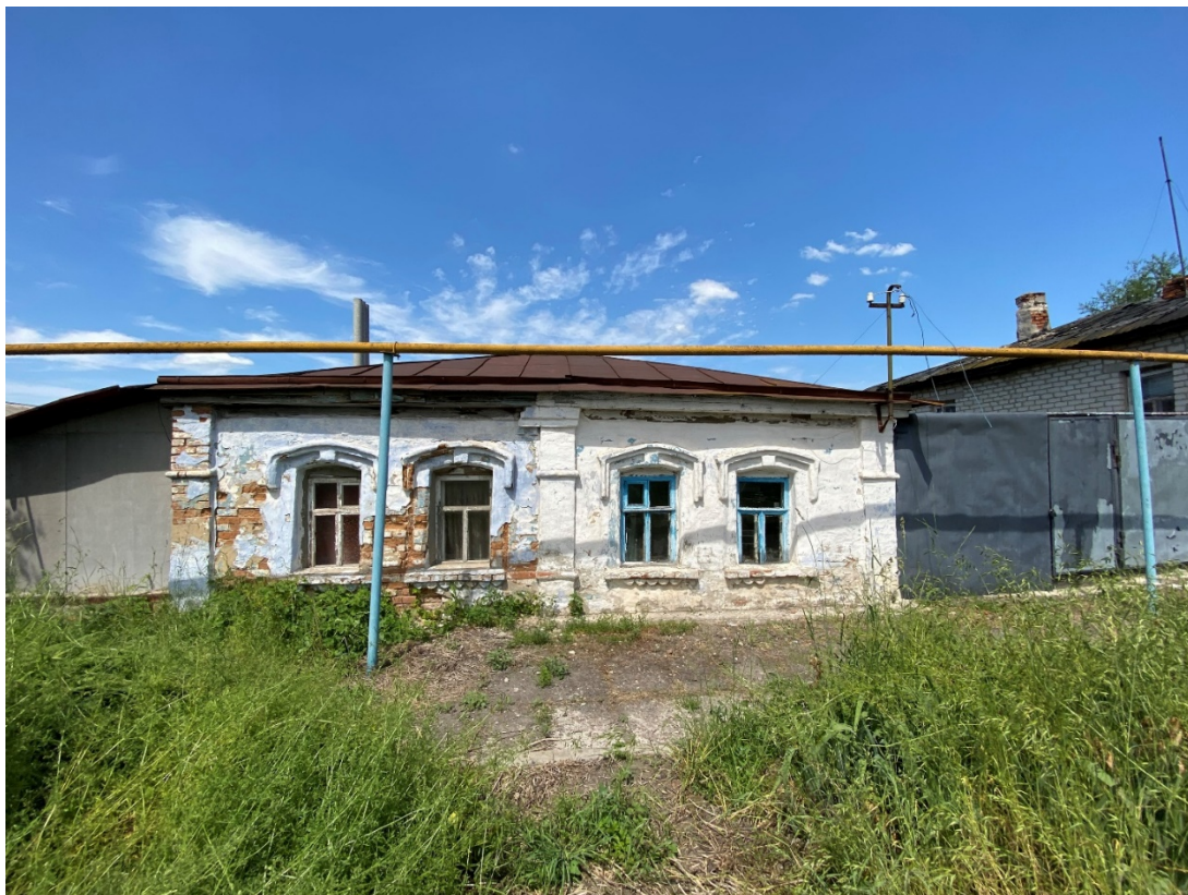
Фотография № 5. Вид с юга на Объект.
