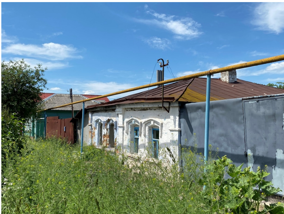
Фотография № 3. Вид с юго-востока на Объект.
