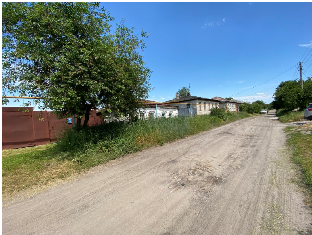
Фотография № 9. Вид с юго-запада на Объект.
