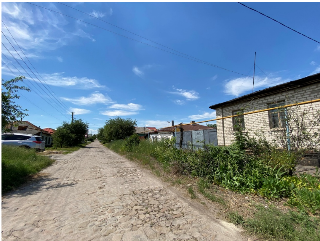
Фотография № 1. Вид с юго-востока на Объект.
