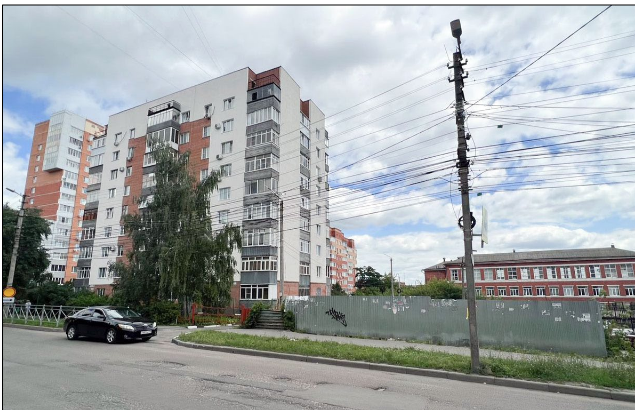
Фотография № 2. Вид с юго-запада на территорию расположения Объекта
