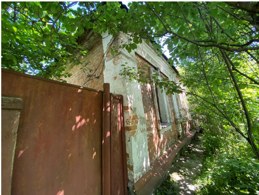
Фотография № 7. Вид с севера на Объект.
