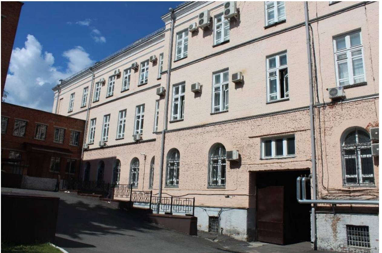
Фото 3. Фрагмент западного фасада здания.
