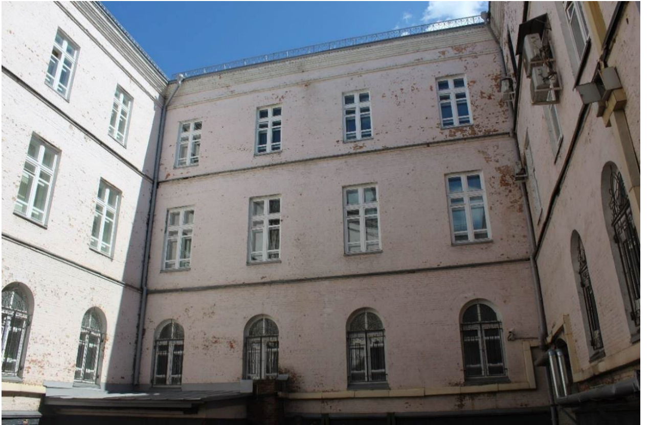
Фото 5. Общий вид фасадов со стороны внутреннего двора.
