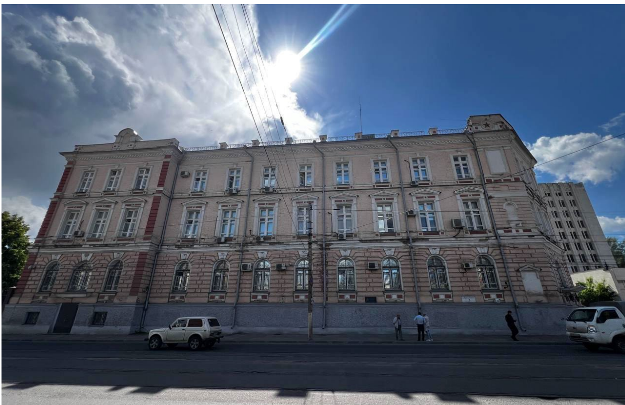
Фото 2. Общий вид Объекта со стороны восточного фасада.
