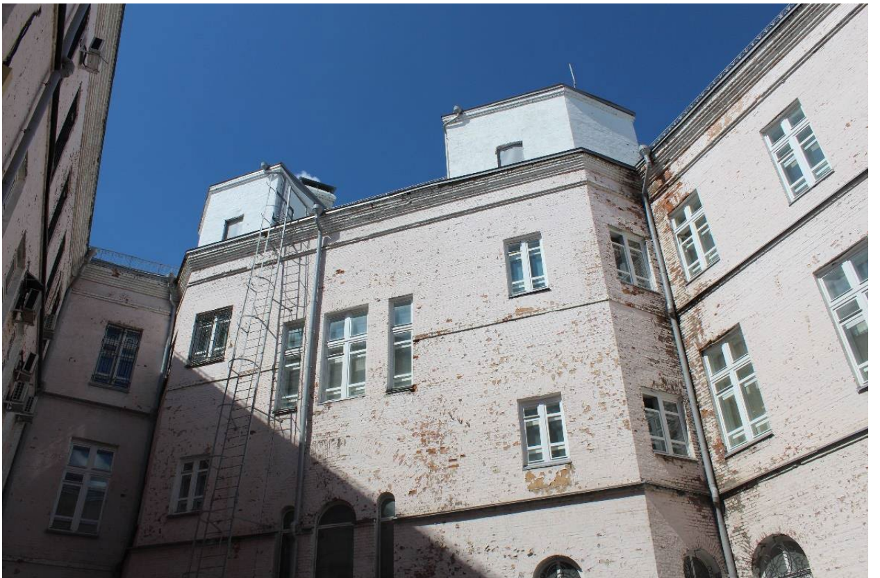
Фото 6. Общий вид фасадов со стороны внутреннего двора.
