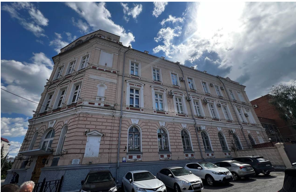
Фото 1. Общий вид Объекта со стороны северного фасада.
