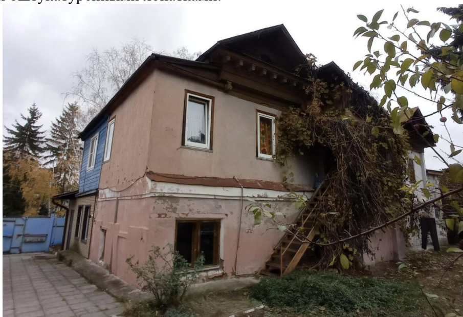
Фрагмент южного фасада. Общий вид
