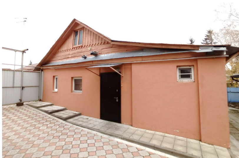
Западный фасад. Общий вид
