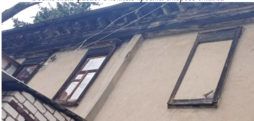
Южный фасад. Оконные проемы второго этажа
