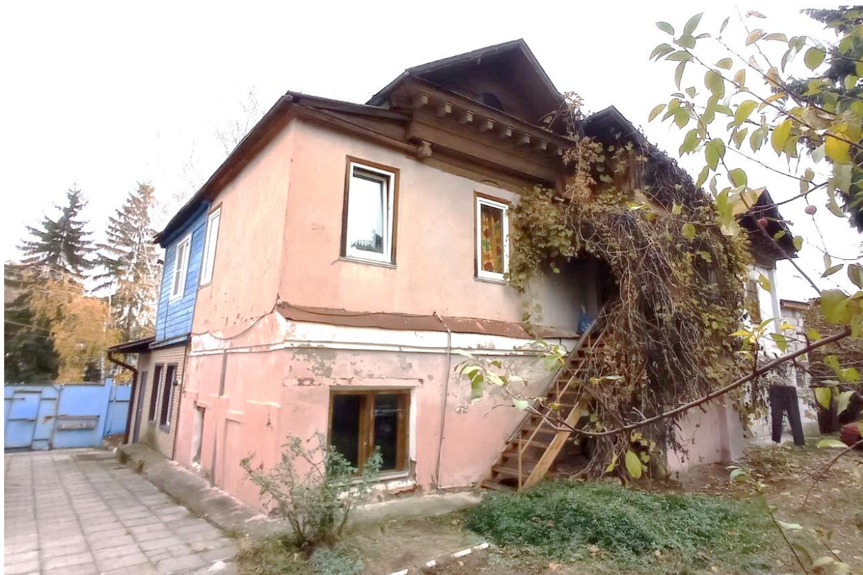
Фото 7. Выявленный объект культурного наследия «Дом жилой», г. Курск, ул. Карла Либкнехта, 30. Западный фасад. Фото Коротеевой Е.В. 11.11.2024 г.
