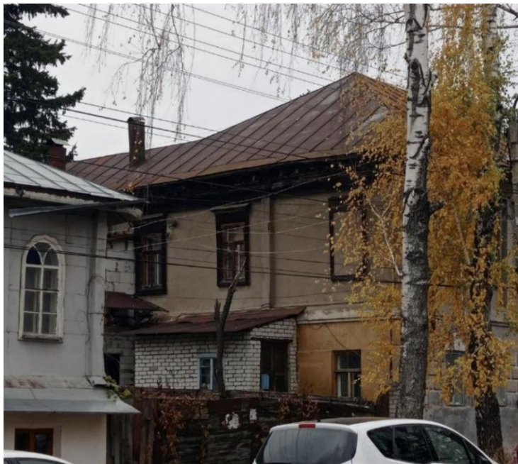
Фрагмент южного фасада. Общий вид
