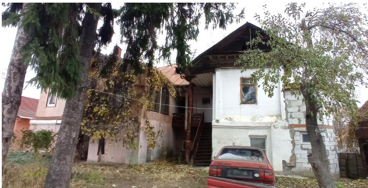
Фото 8. Выявленный объект культурного наследия «Дом жилой», г. Курск, ул. Карла Либкнехта, 30. Западный фасад. Фото Коротеевой Е.В. 11.11.2024 г.
