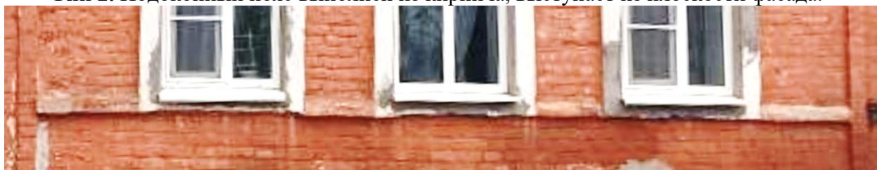
Восточный фасад. Подоконный пояс
