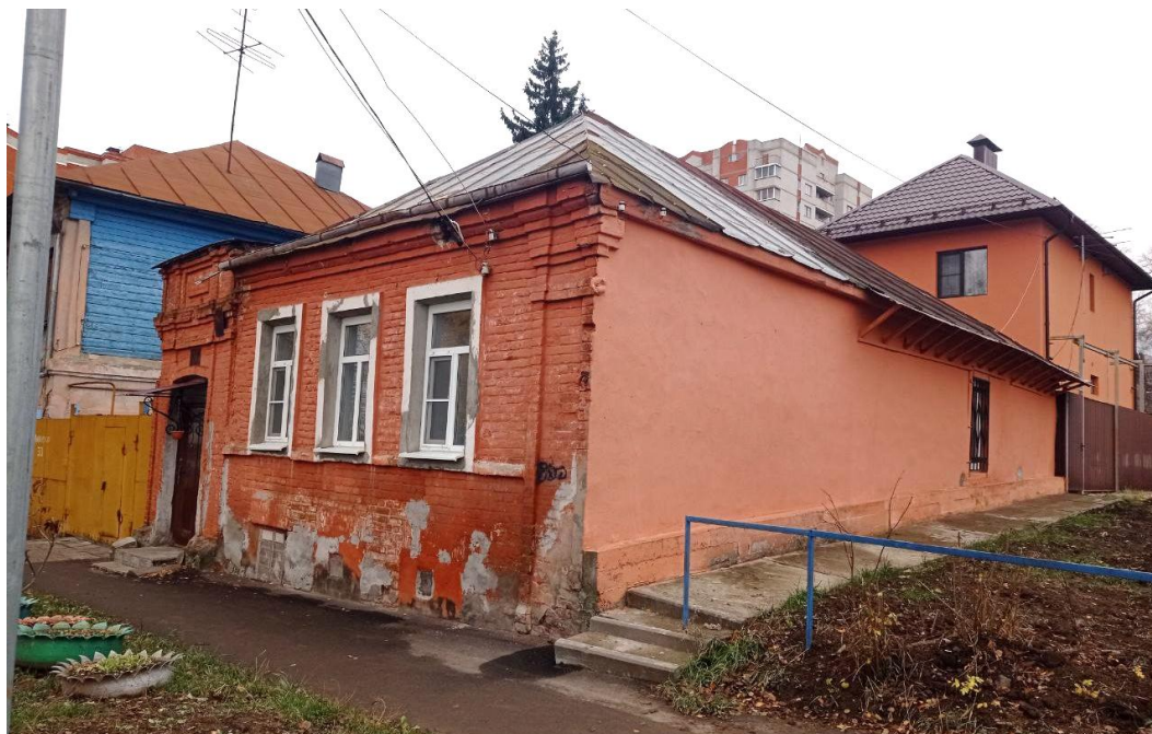
Фото 17. Выявленный объект культурного наследия «Дом жилой», г. Курск, ул. Карла Либкнехта, 30а. Северный и восточный фасады. Фото Коротеевой Е.В. 11.11.2024 г.
