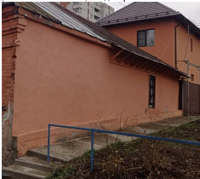
Северный фасад. Общий вид
