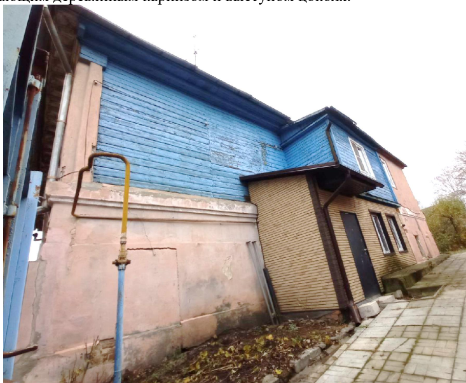
Северный фасад. Общий вид
