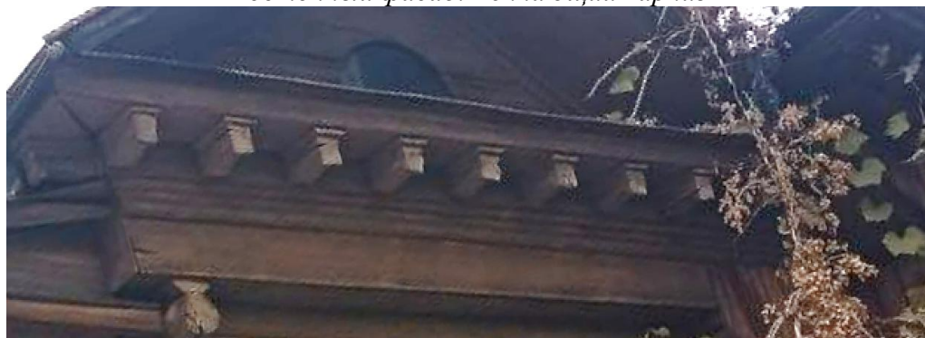
Западный фасад. Венчающий карниз
