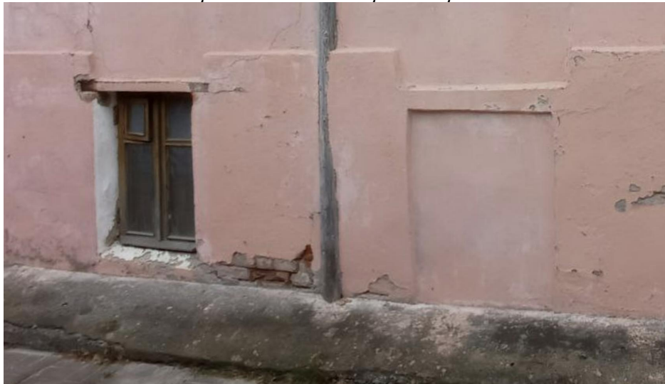
Северный фасад. Оконные проемы первого этажа
