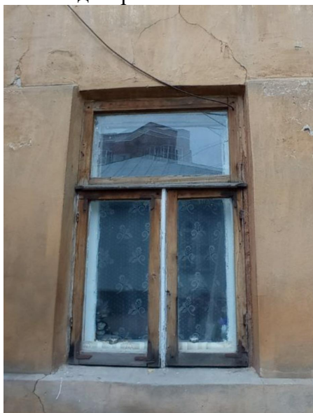
Южный фасад. Оконный проем первого этажа
