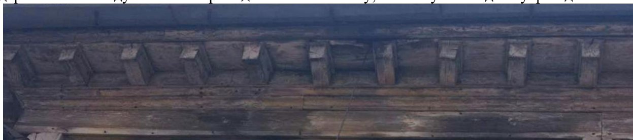
Восточный фасад. Венчающий карниз
