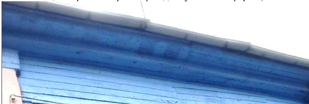
Северный фасад. Венчающий карниз
