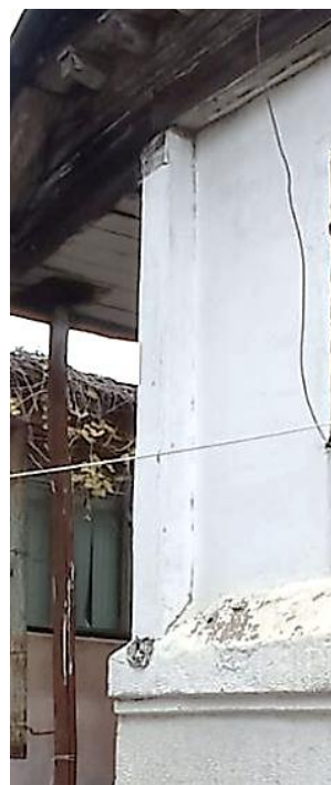
Западный фасад. Лопатка второго этажа
