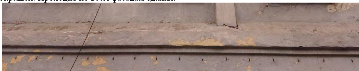
Восточный фасад. Межэтажный карниз
