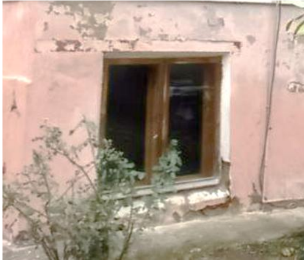
Западный фасад. Оконный проем первого этажа
