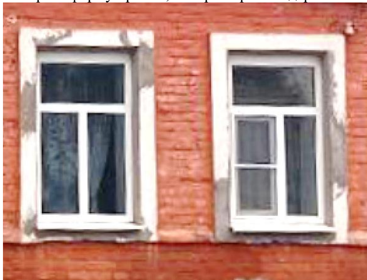
Восточный фасад. Оконные проемы
