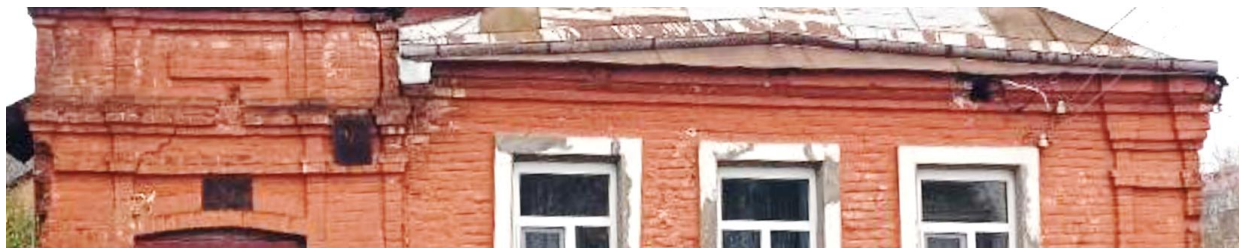
Восточный фасад. Венчающий карниз
