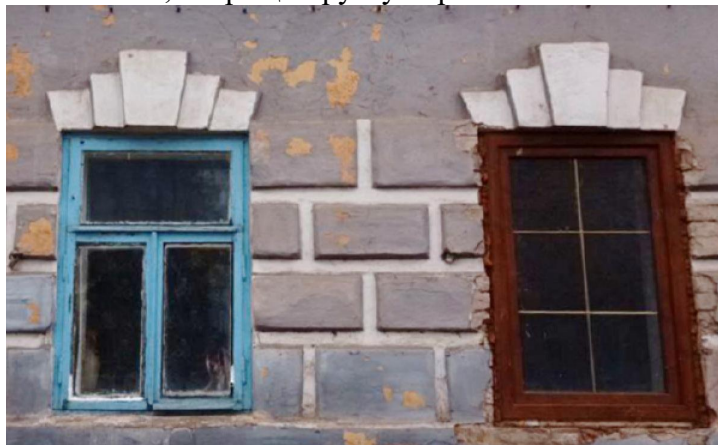
Дом № 30. Восточный фасад. Оконные проемы первого этажа
