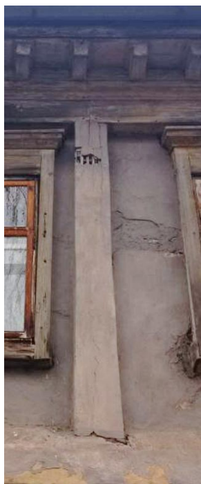
Восточный фасад. Лопатка второго этажа
