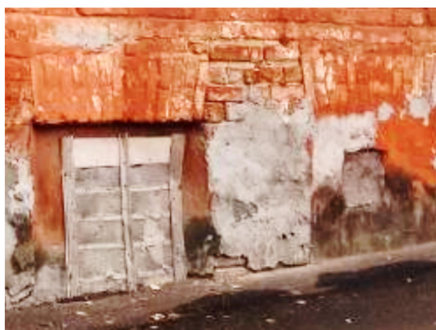
Восточный фасад. Оконные проемы
