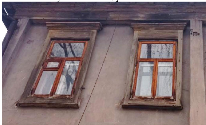
Восточный фасад. Оконные проемы второго этажа
