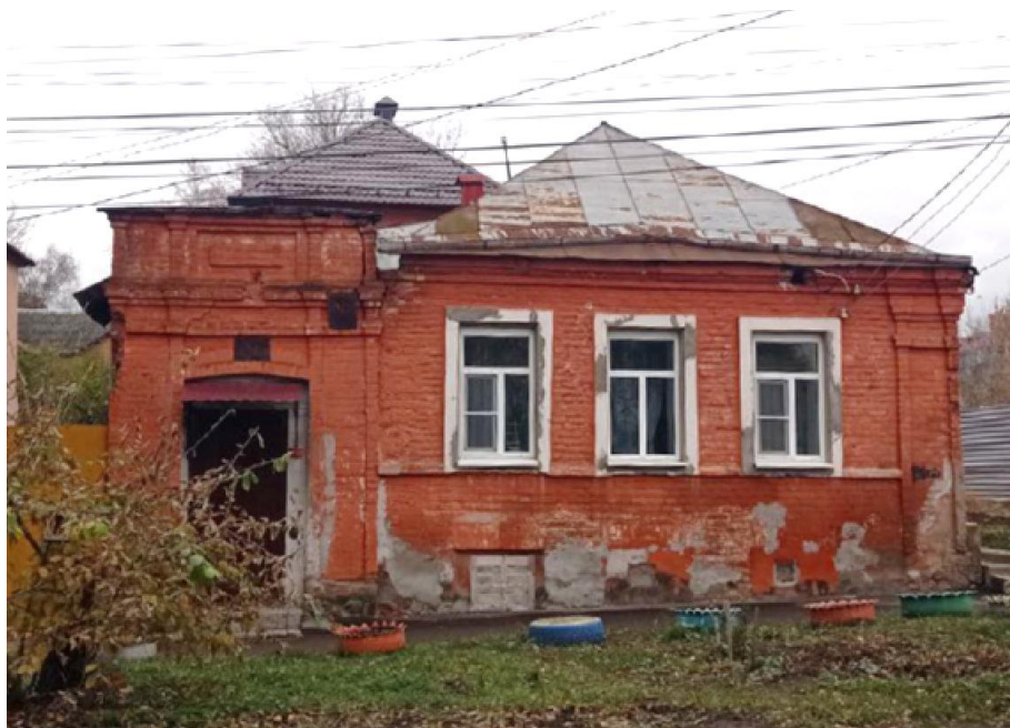
Главный (восточный) фасад. Общий вид
