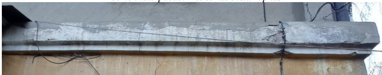
Южный фасад. Межэтажный карниз
