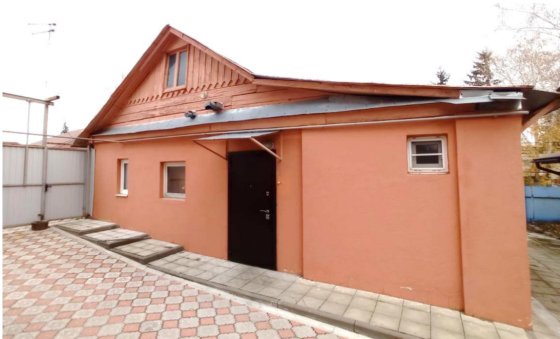
Фото 19. Выявленный объект культурного наследия «Дом жилой», г. Курск, ул. Карла Либкнехта, 30а. Западный фасад. Фото Коротеевой Е.В. 11.11.2024 г.
