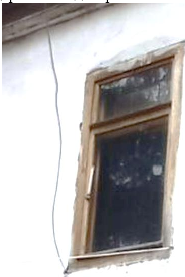
Восточный фасад. Оконный проем второго этажа
