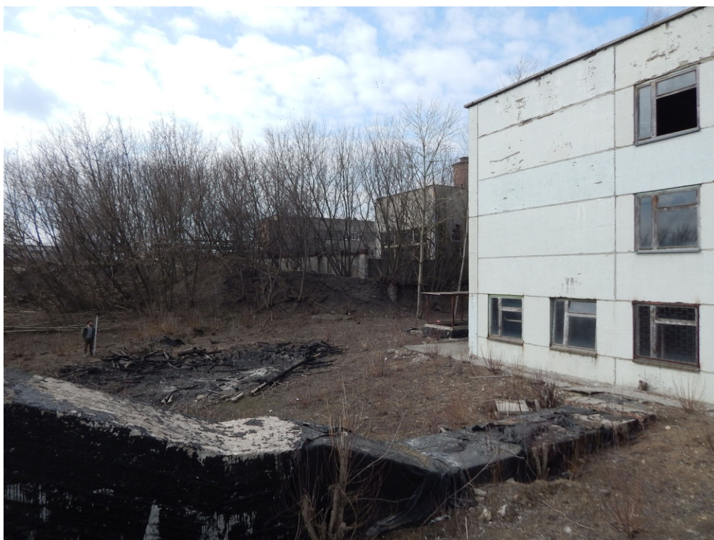
Илл. 30. КРО-2021. Г. Курск. Просп. Кулакова. Общий вид участка обследования. Точка № 5. Снимок № 2. Вид с ВЮВ.
