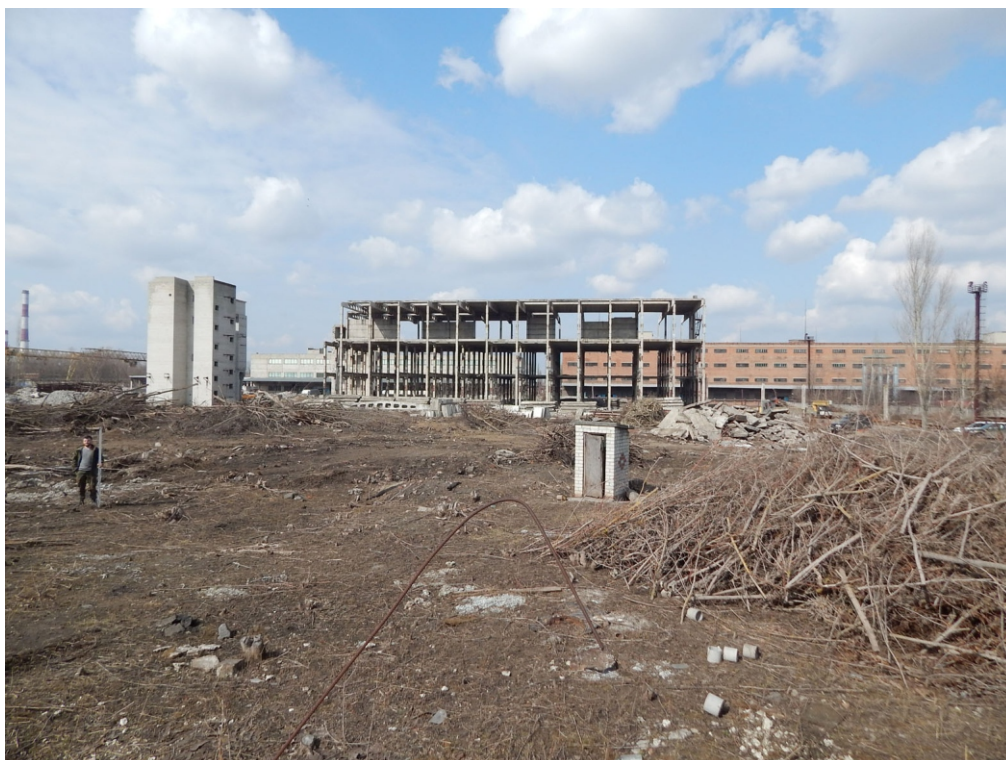
Илл. 19. КРО-2021. Г. Курск. Просп. Кулакова. Общий вид участка обследования. Точка № 3. Снимок № 1. Вид с ВЮВ.
