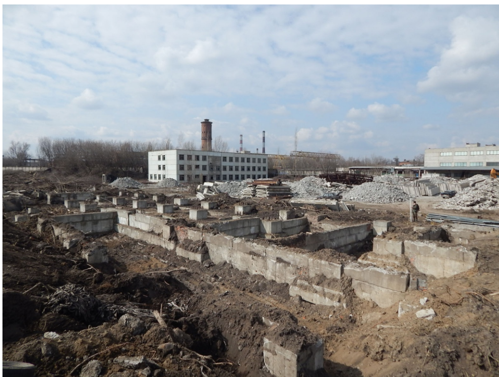
Илл. 24. КРО-2021. Г. Курск. Просп. Кулакова. Общий вид участка обследования. Точка № 4. Снимок № 2. Вид с ВЮВ.
