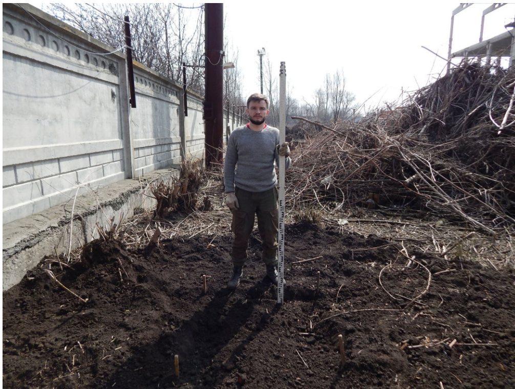
Илл. 51. КРО-2021. Г. Курск. Просп. Кулакова. Шурф № 2. Рабочий момент. Вид после засыпки С.
