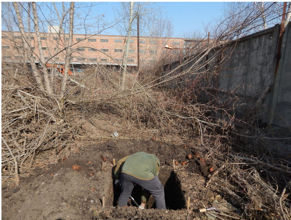
Илл. 44. КРО-2021. Г. Курск. Просп. Кулакова. Шурф № 1. Рабочий момент. Вид на зачистку с Ю.
