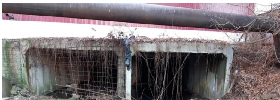
Фото 14. Характер поймы р. Кур у входного оголовка тоннеля.
