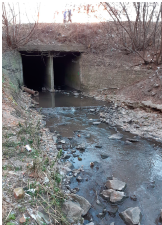
Фото 15. Характер поймы р. Кур у выходного оголовка тоннеля
