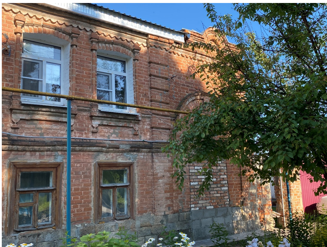
Фотография № 10. Вид с северо-запада на Объект. Центральный (западный) фасад. Фрагмент.
