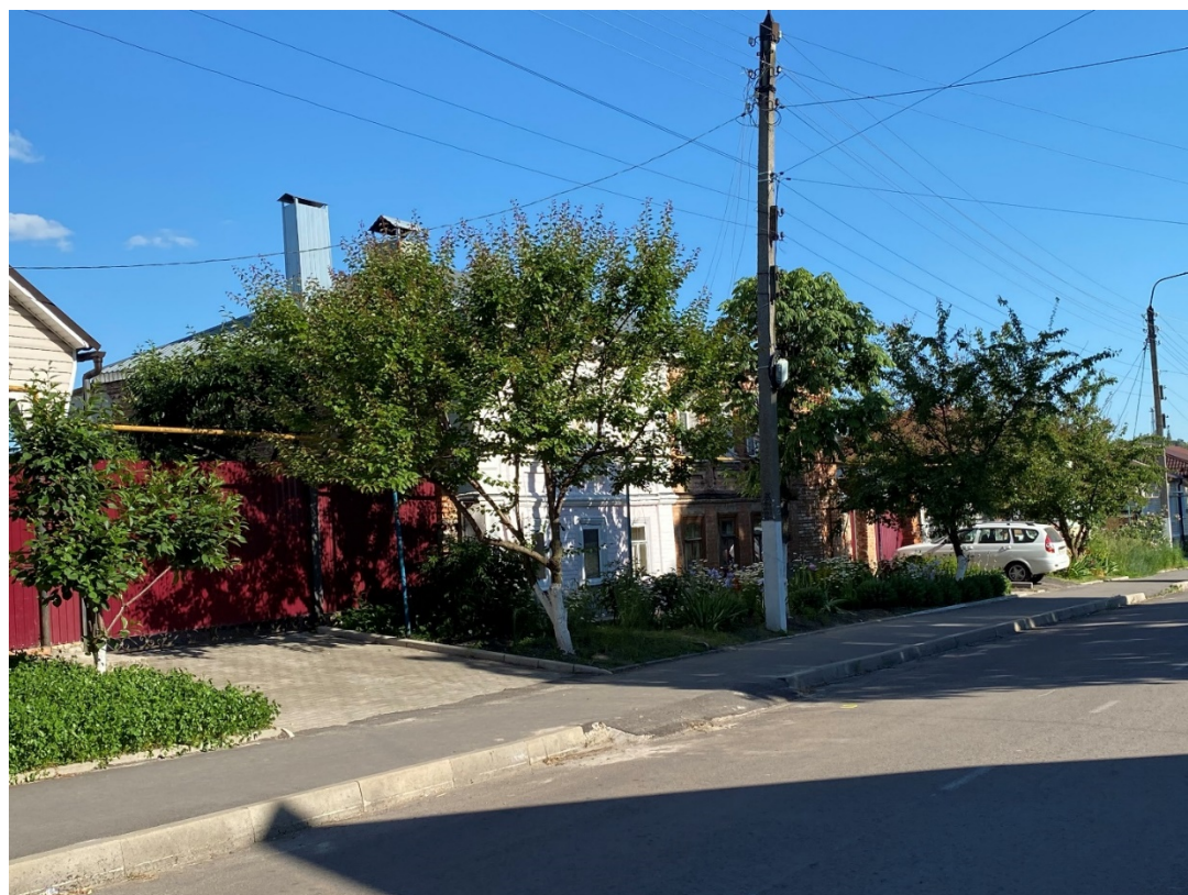
Фотография № 2. Вид с северо-запада на Объект.
