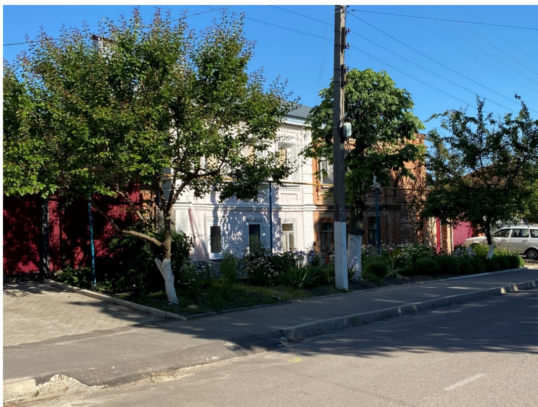
Фотография № 4. Вид с северо-запада на Объект.
