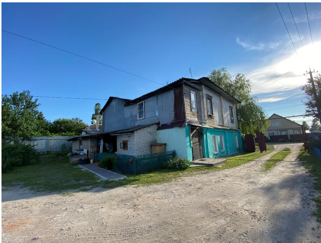
Фотография № 5. Вид с северо-востока на Объект. Угол северного и восточного фасадов.
