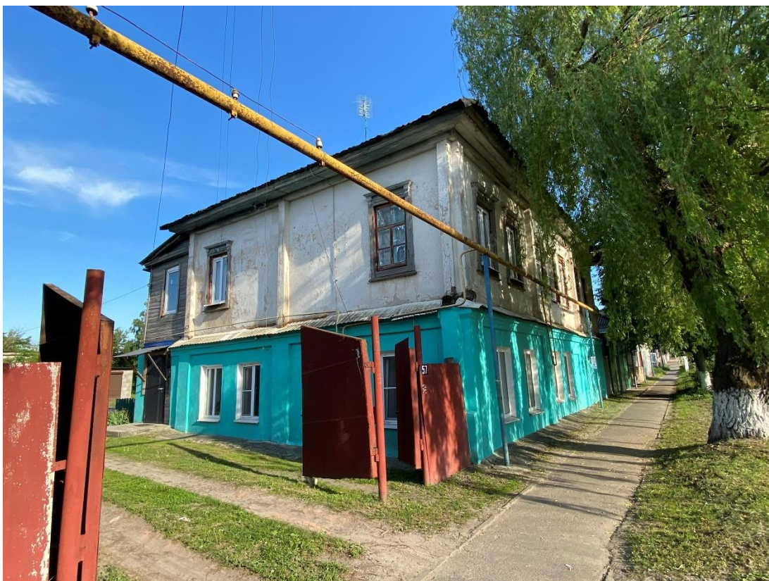
Фотография № 3. Вид с северо-запада на Объект. Угол северного и западного фасадов.
