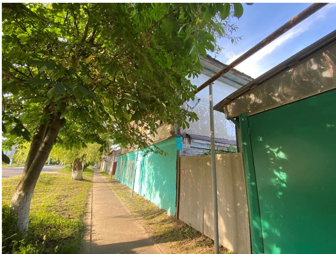
Фотография № 8. Вид с юга на Объект. Западный фасад.
