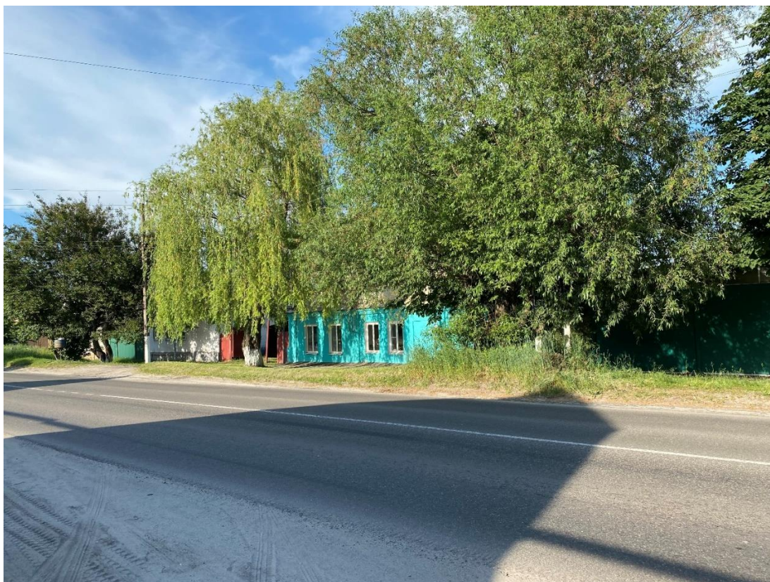
Фотография № 9. Вид с юго-запада на Объект.
