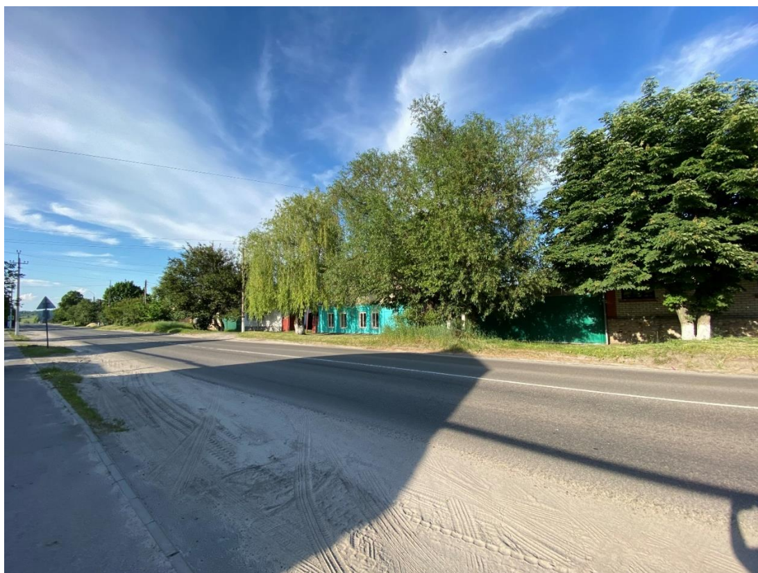
Фотография № 10. Вид с юго-запада на Объект.
