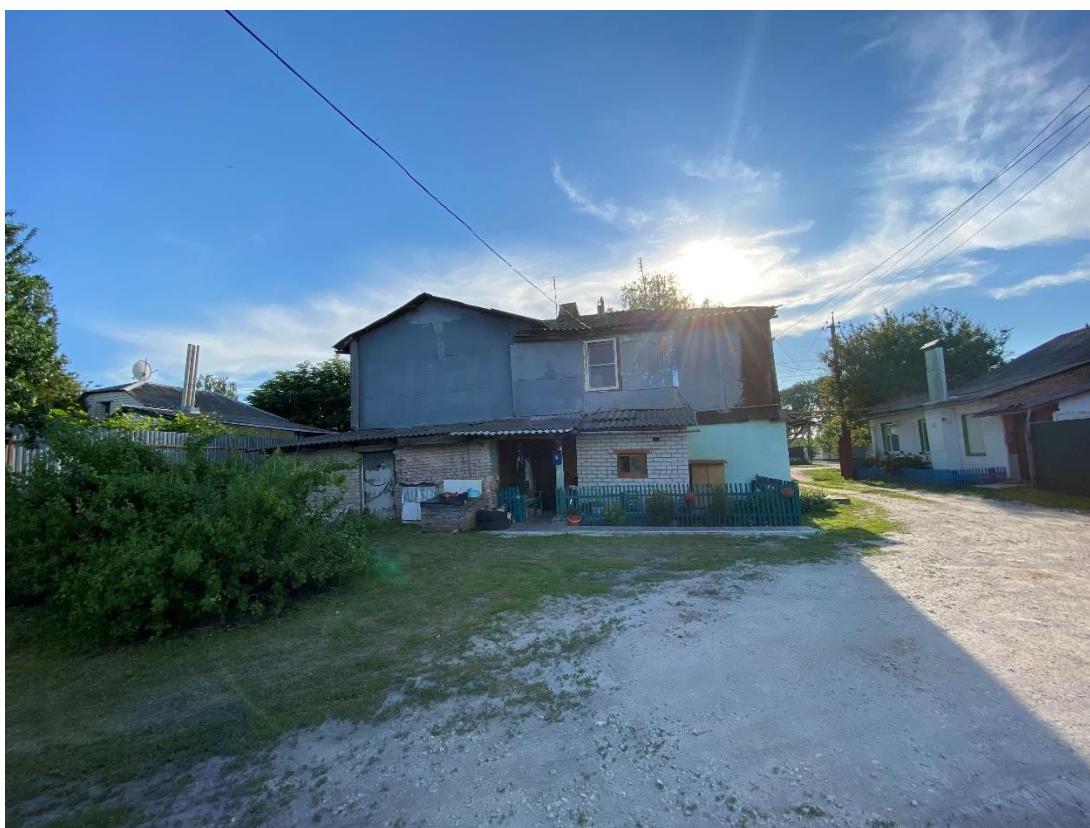
Фотография № 6. Вид с востока на Объект. Восточный фасад.
