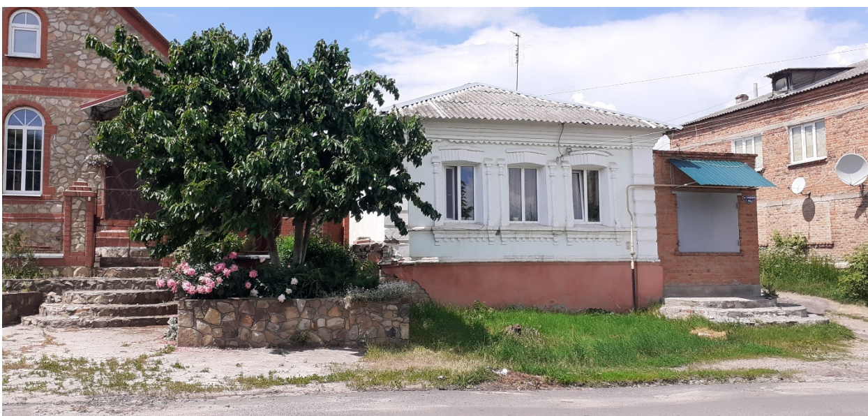
Фотография № 8. Вид с юго-востока на Объект.
