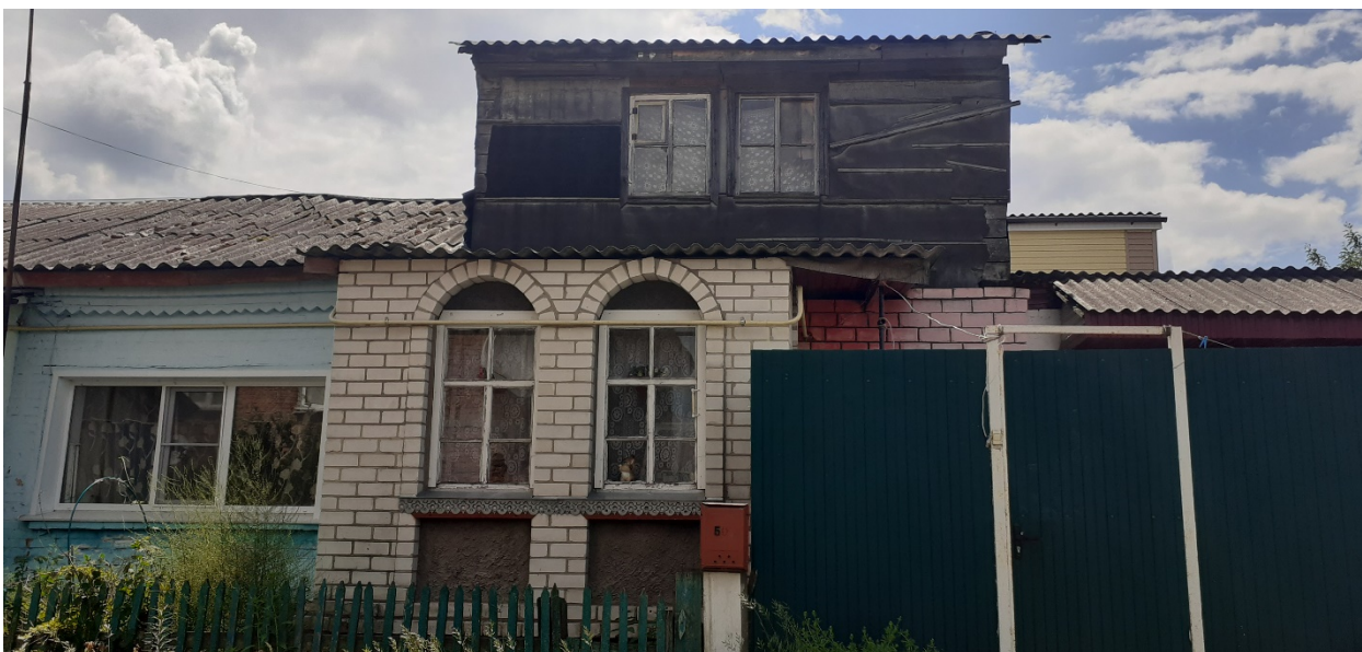
Фотография № 4. Вид с севера на Объект.
