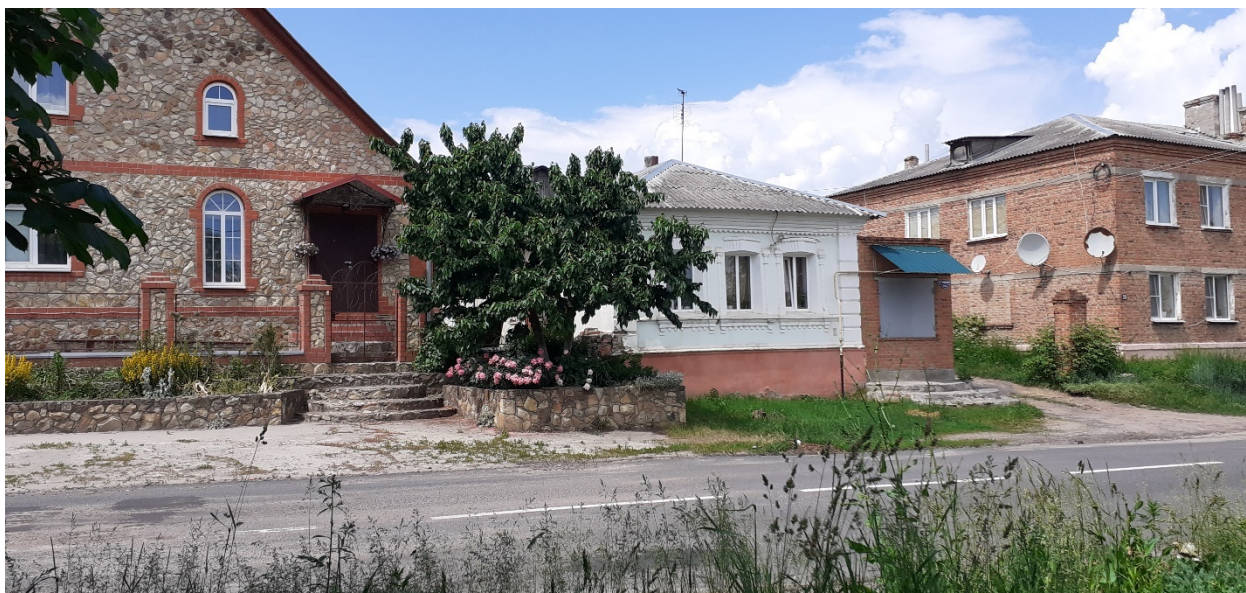
Фотография № 9. Вид с юго-востока на Объект.
