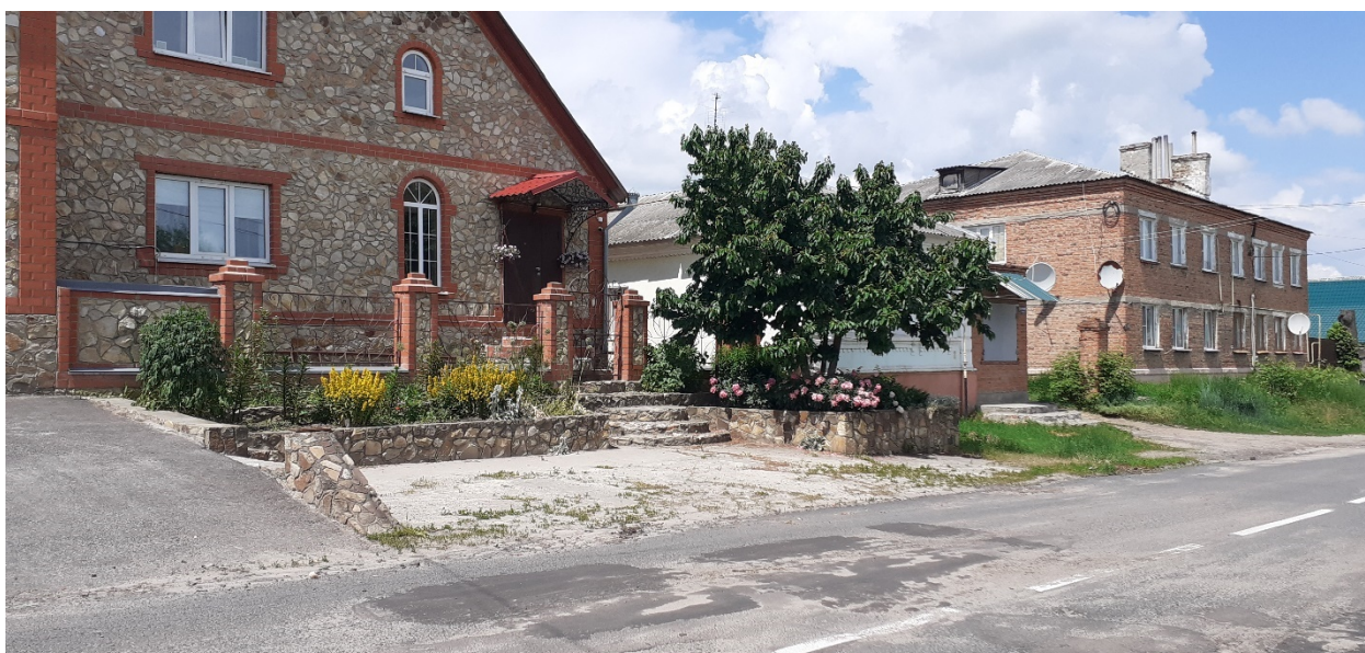
Фотография № 10. Вид с юго-запада на Объект.
