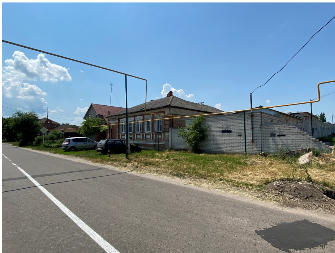
Фотография № 7. Вид с северо-востока на Объект.
