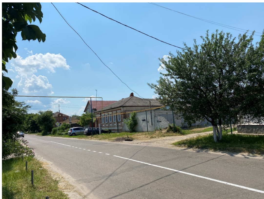
Фотография № 8. Вид с северо-востока на Объект.
