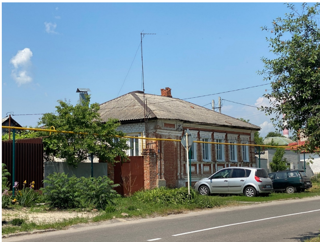
Фотография № 3. Вид с юго-востока на Объект.
