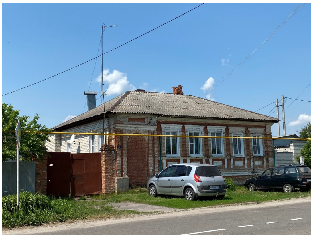
Фотография № 4. Вид с юго-востока на Объект.
