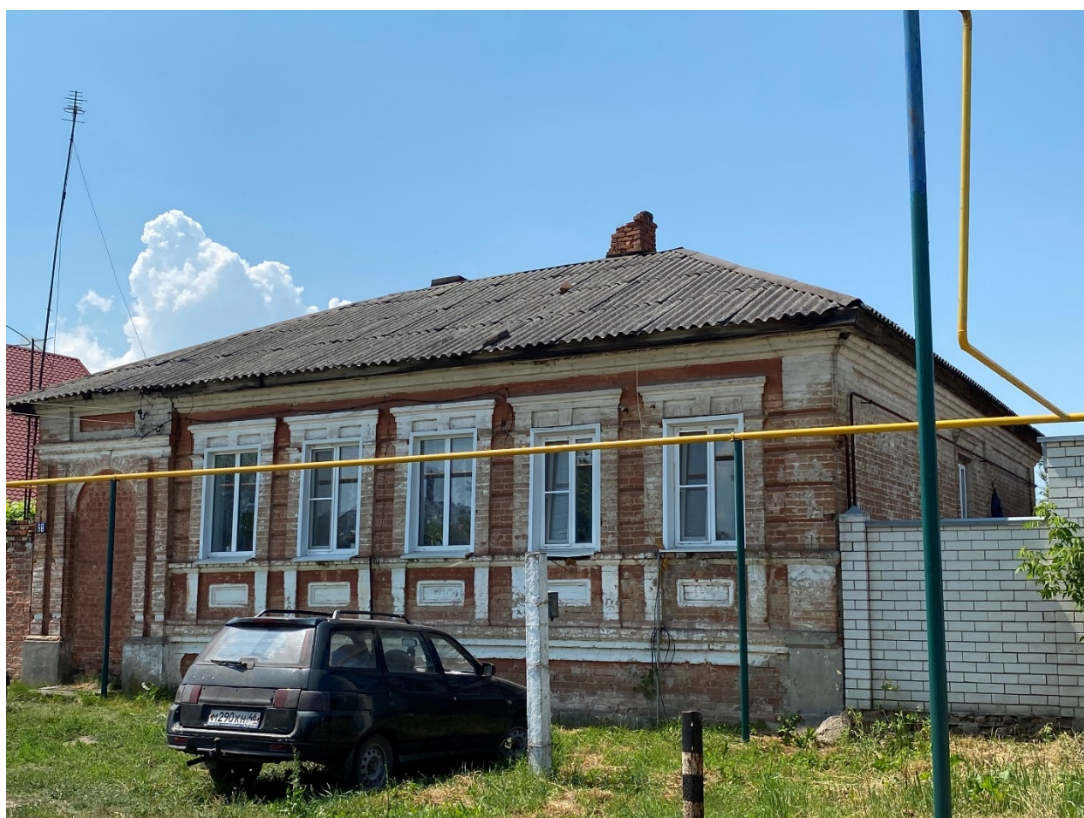
Фотография № 6. Вид с северо-востока на Объект.
