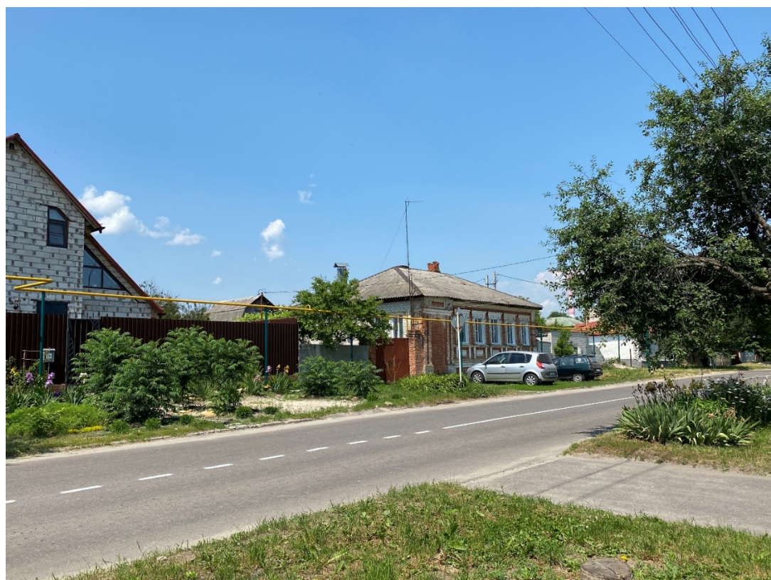
Фотография № 2. Вид с юго-востока на Объект.
