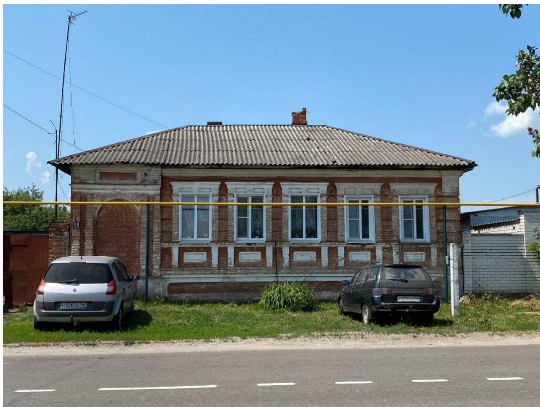
Фотография № 5. Вид с востока на Объект.
