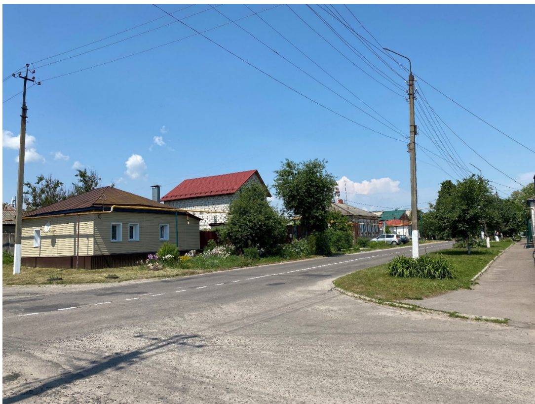
Фотография № 1. Вид с юго-востока на Объект.
