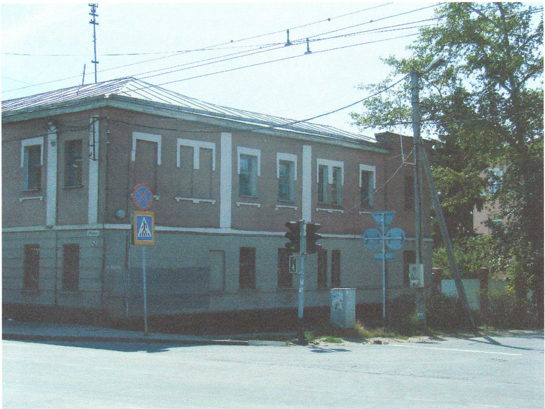
1. «Дом жилой». г. Курск, ул. Радищева, 42. Общий вид.
