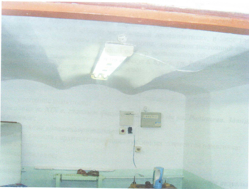
3. «Дом жилой». г. Курск, ул. Радищева, 42. Своды подвальной части.
