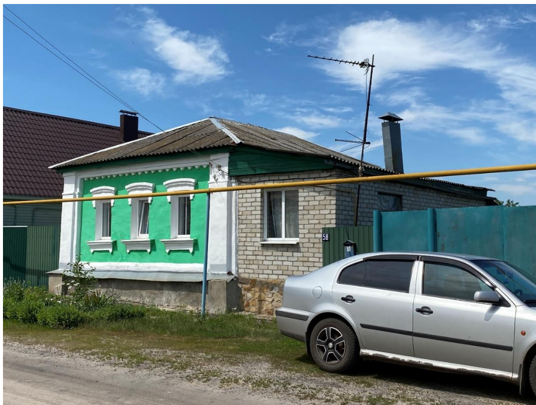
Фотография № 4. Вид с юго-востока на Объект.
