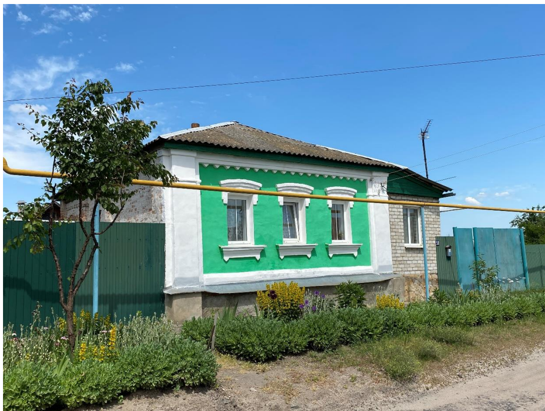
Фотография № 7. Вид с юго-запада на Объект.
