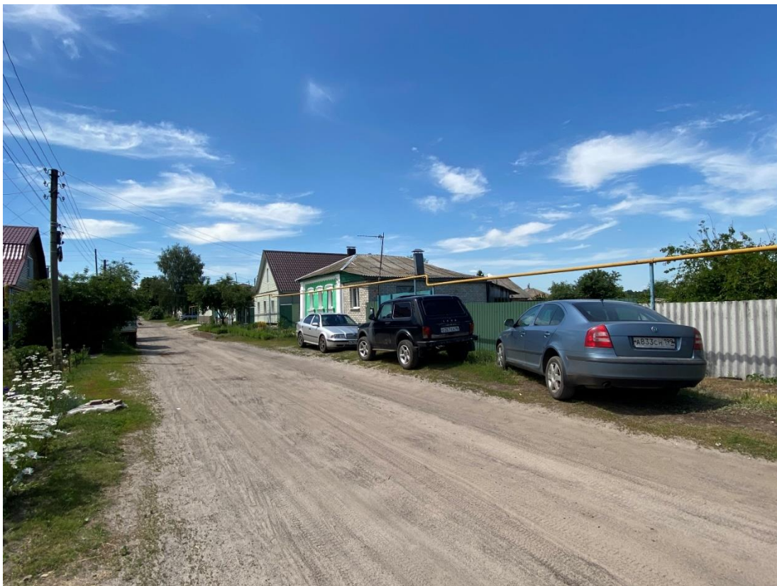
Фотография № 1. Вид с юго-востока на Объект.
