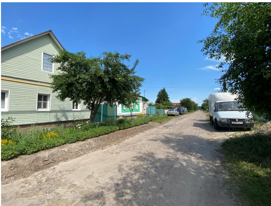
Фотография № 10. Вид с юго-запада на Объект.
