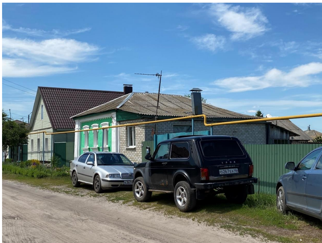
Фотография № 2. Вид с юго-востока на Объект.
