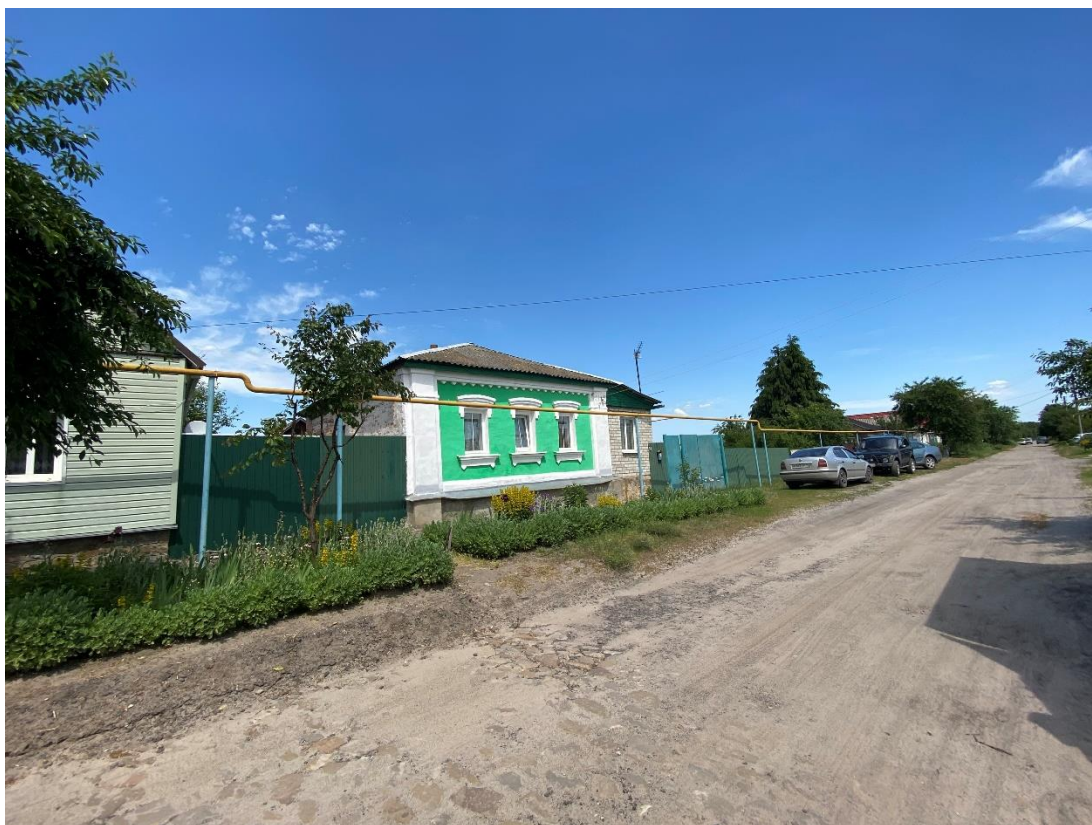
Фотография № 9. Вид с юго-запада на Объект.
