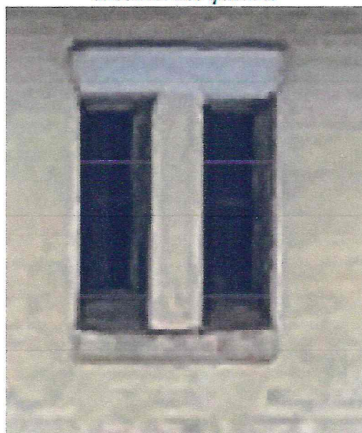
Заполнение оконных проемов боковых объемов. Все фасады
