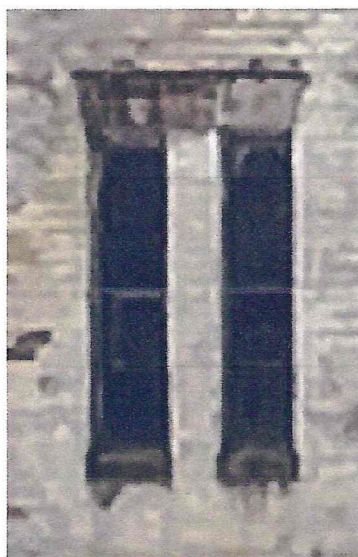
Заполнение оконных проемов боковых объемов. Все фасады
