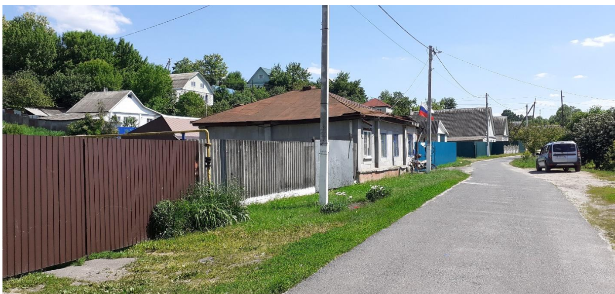
Фотография № 9. Вид с северо-запада на Объект.
