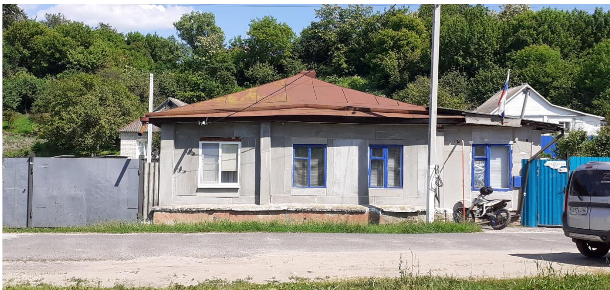
Фотография № 6. Вид с запада на Объект.
