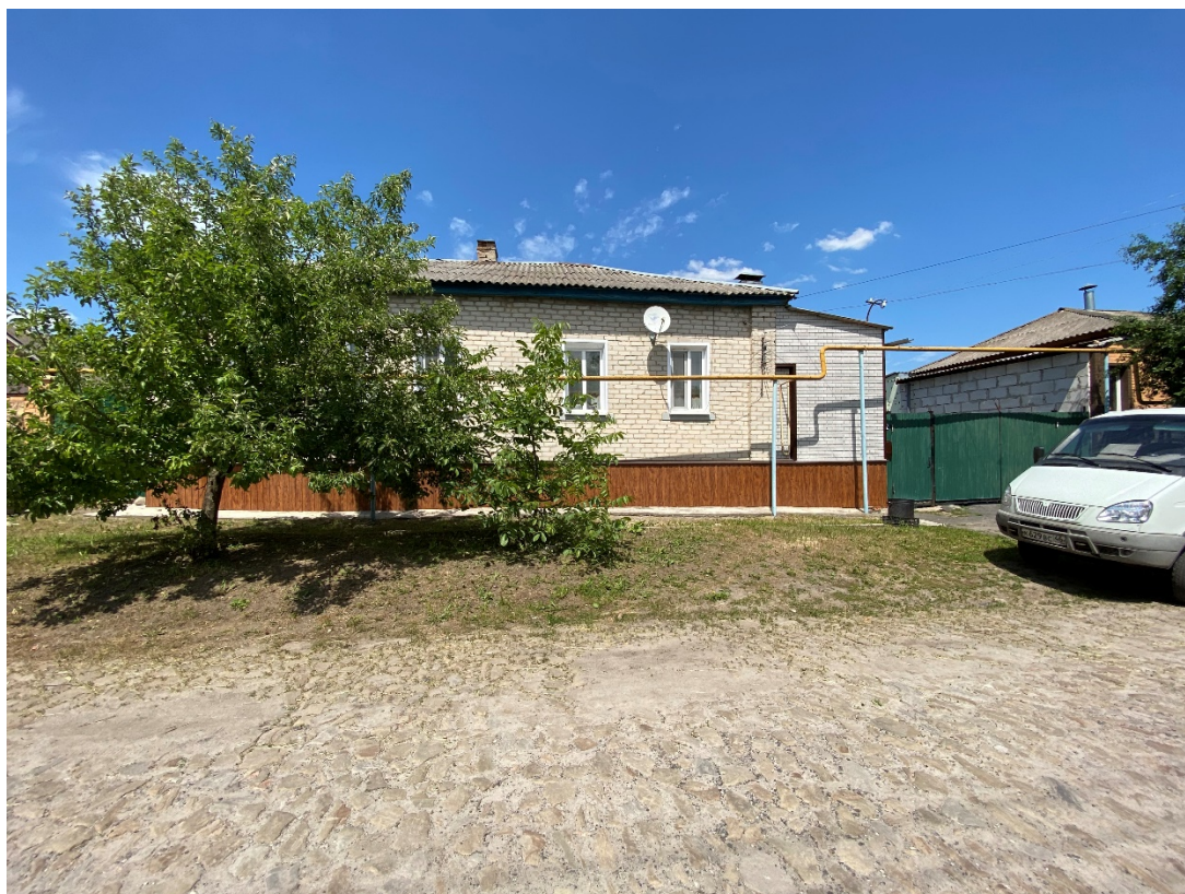
Фотография № 5. Вид с юго-запада.
