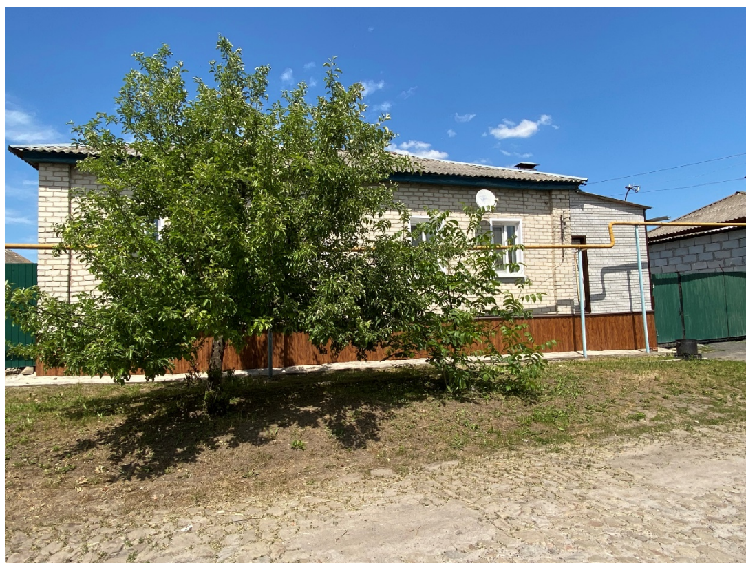
Фотография № 6. Вид с юго-запада.
