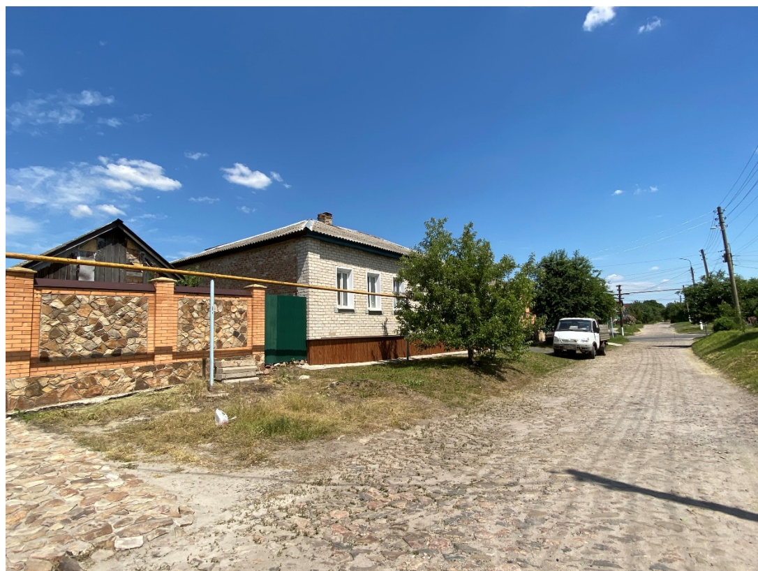
Фотография № 10. Вид с юго-запада.
