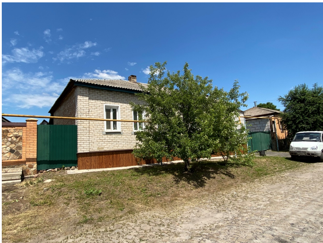
Фотография № 8. Вид с юго-запада.
