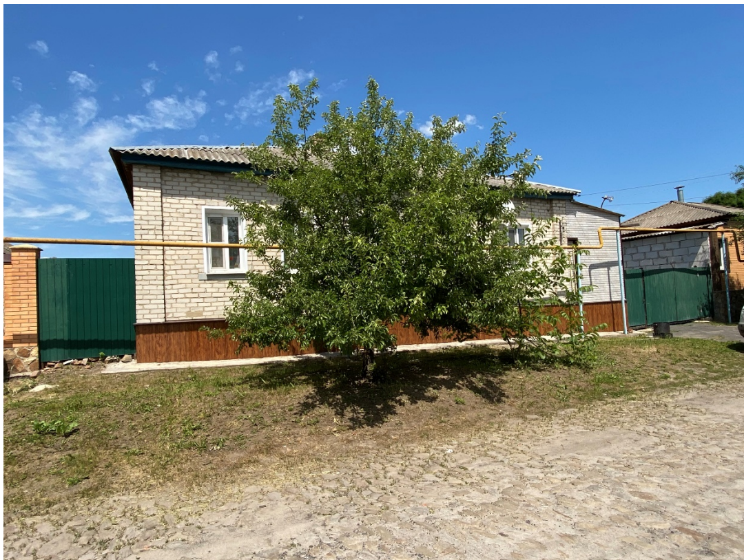
Фотография № 7. Вид с юго-запада.
