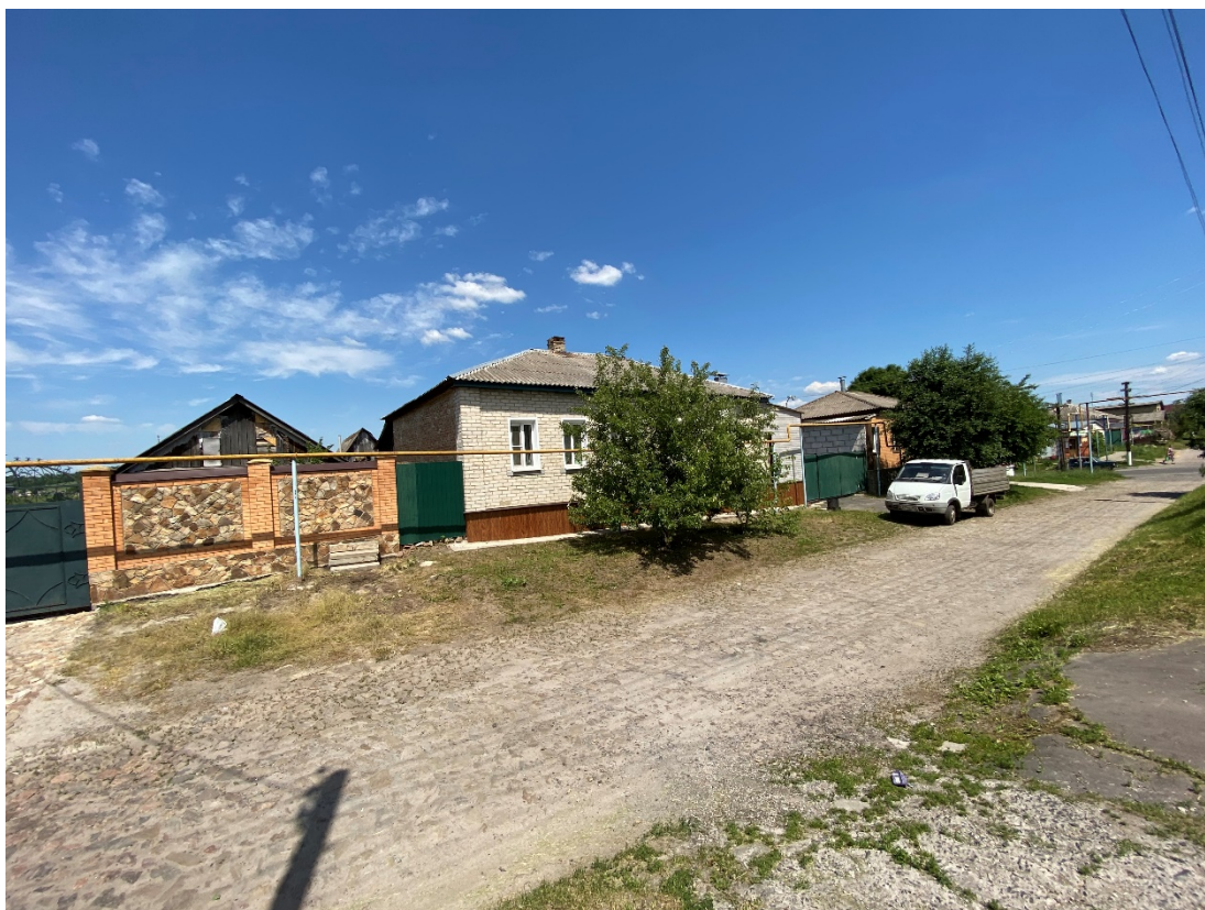
Фотография № 9. Вид с юго-запада.
