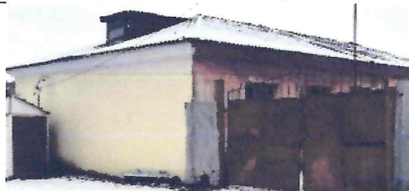
композиция дворового фасада
