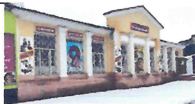
Композиция главного фасада
