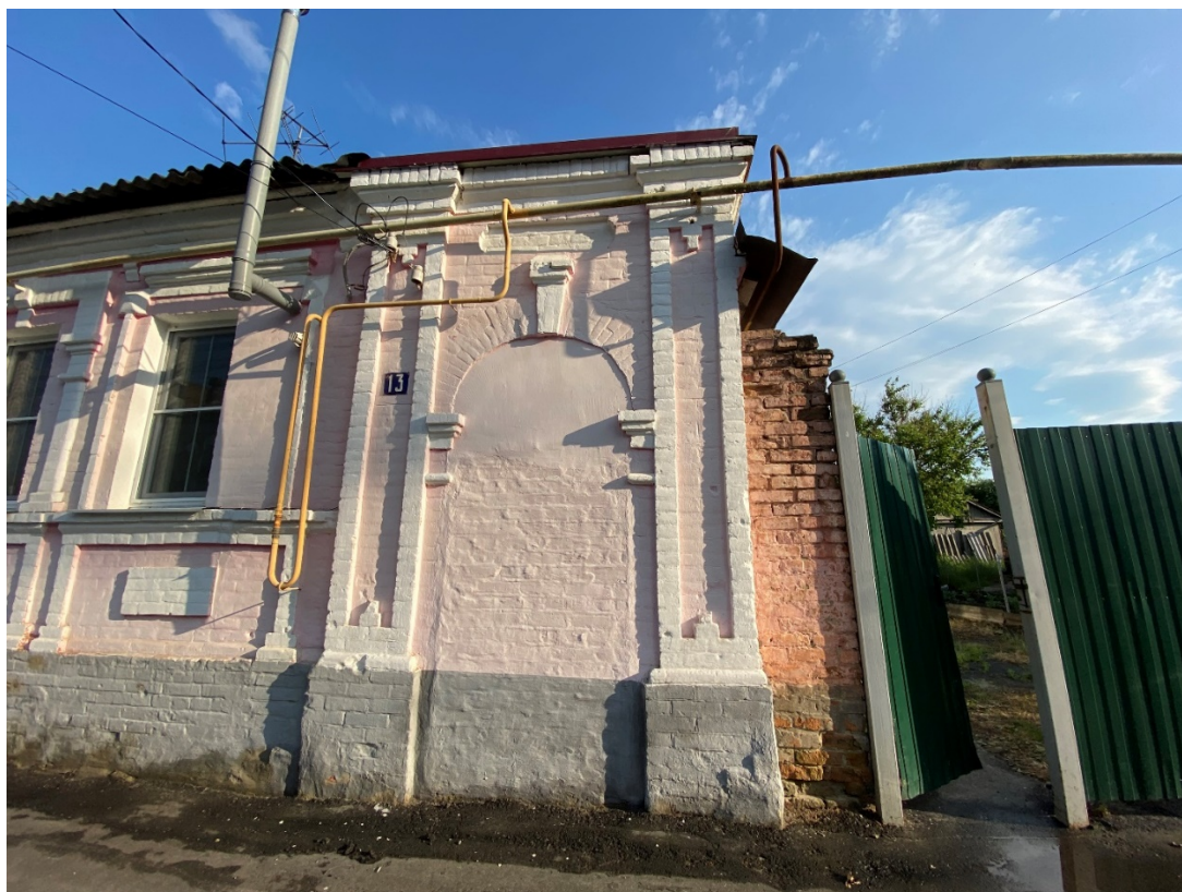
Фотография № 11. Вид с севера на Объект. Центральный (северный) фасад. Фрагмент.
