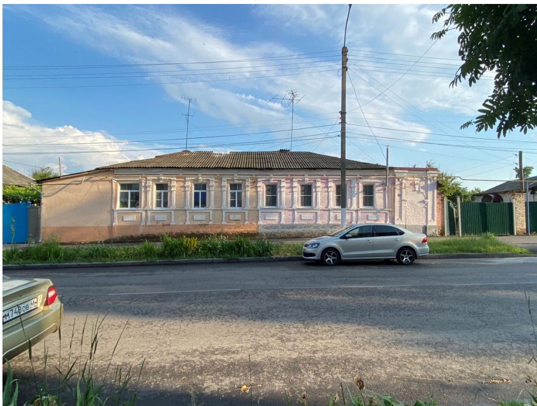
Фотография № 6. Вид с севера на Объект.
