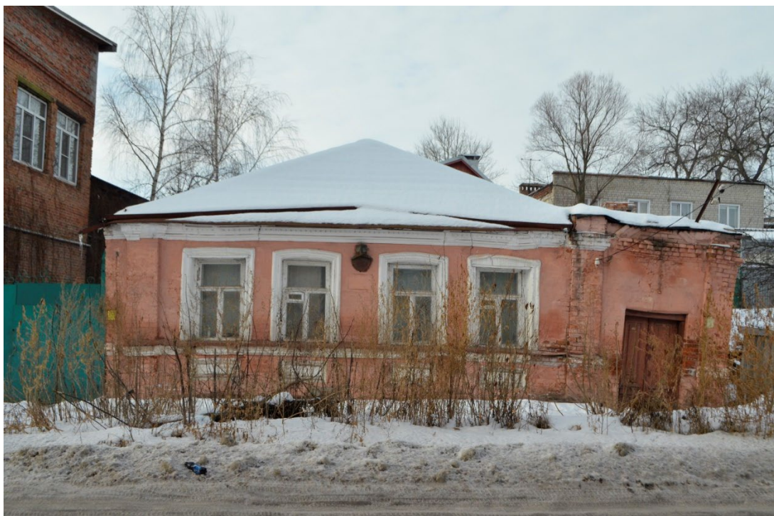
Т.ф. 3. Вид с северо-востока со стороны ул. Гайдара на главный фасад Объекта
