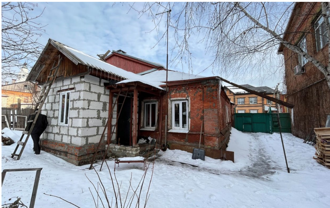
Т.ф. 11. Вид с юго-запада в сторону ул. Гайдара на юго-западный фасад Объекта
