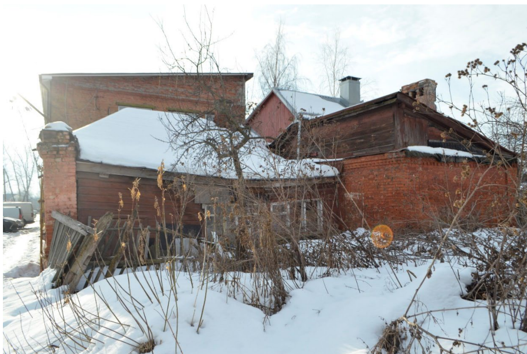
Т.ф. 6. Вид с севера на пристройку к северо-западному фасаду Объекта
