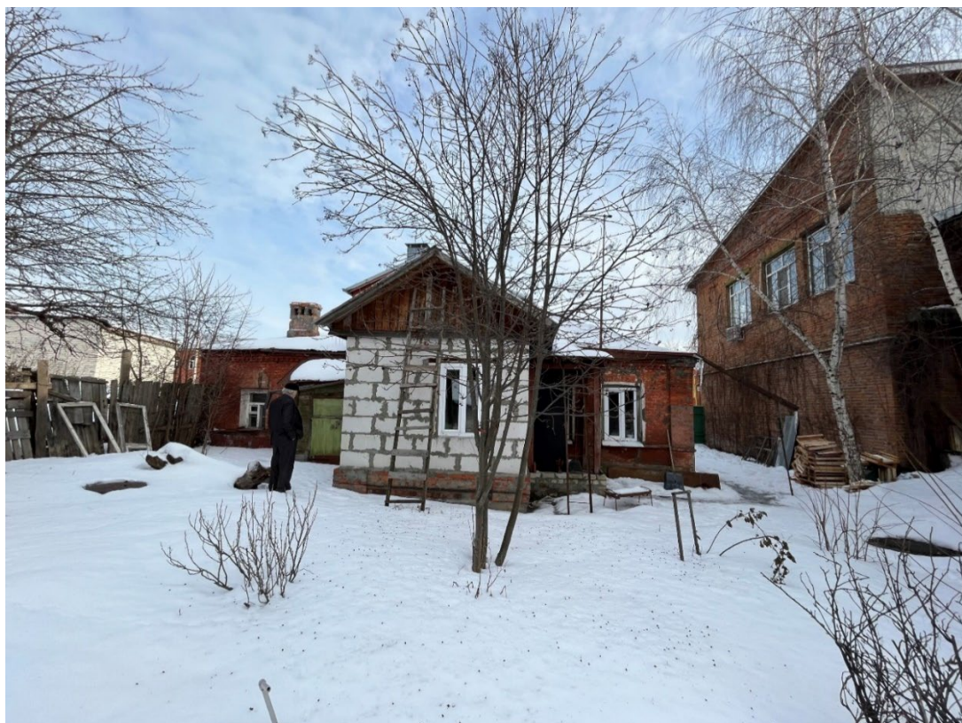
Т.ф. 10. Вид с юго-запада на юго-западный фасад Объекта
