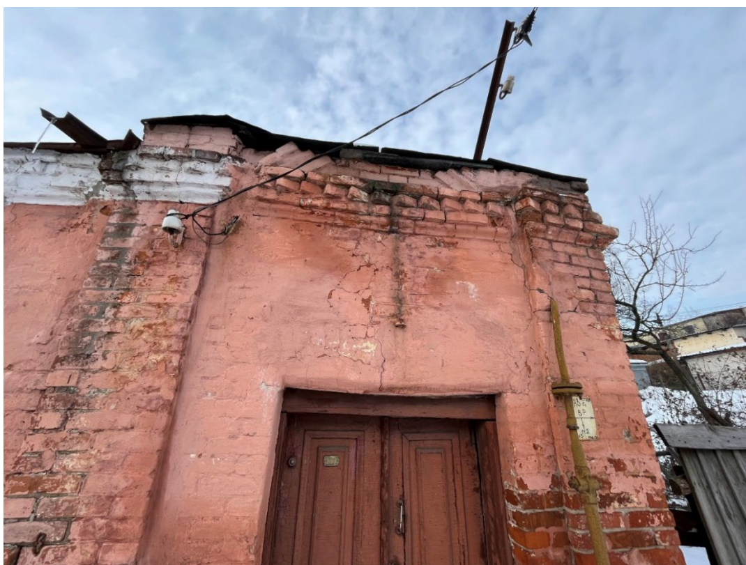
Т.ф. 16. Вид с северо-востока со стороны ул. Гайдара на детали главного фасада Объекта
