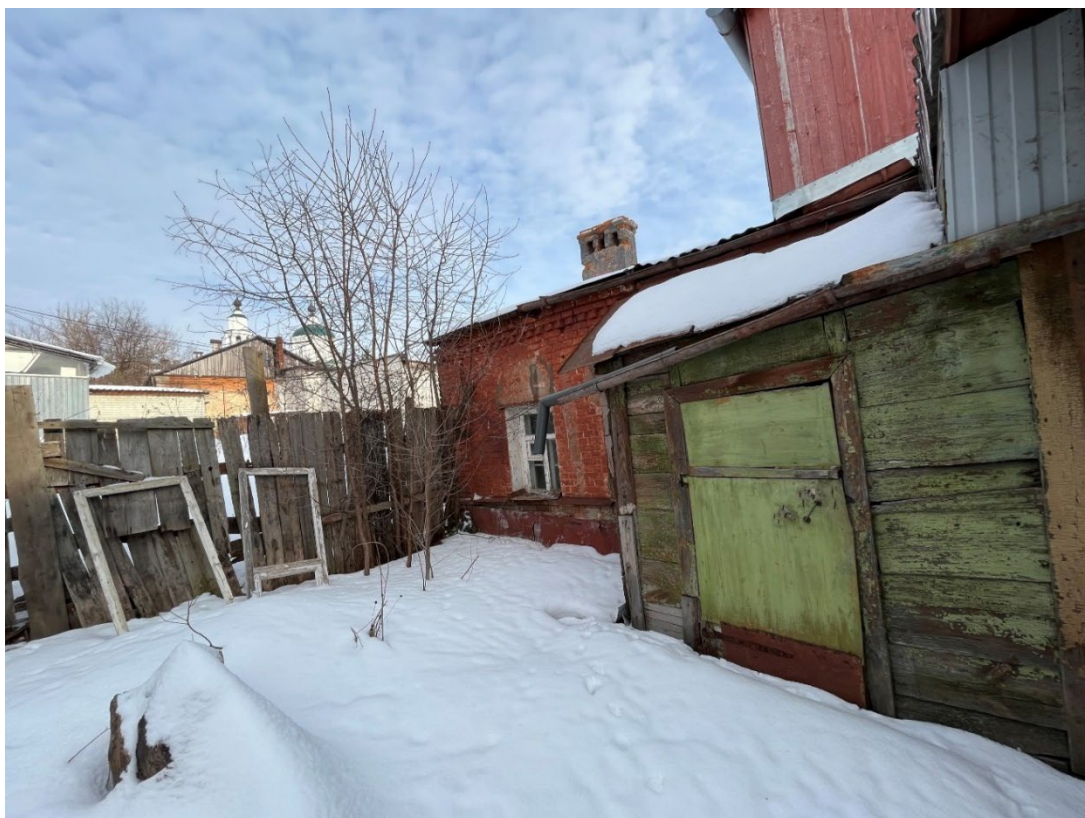
Т.ф. 9. Вид с запада на дворовый фасад Объекта с пристройкой
