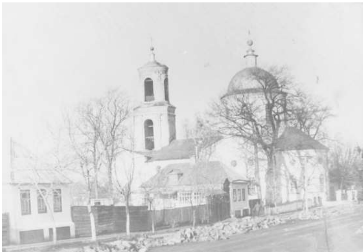
15. Троицкая церковь г. Суджа. Фотография, 1960 г.
