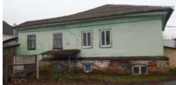
композиция юго-восточного фасада
