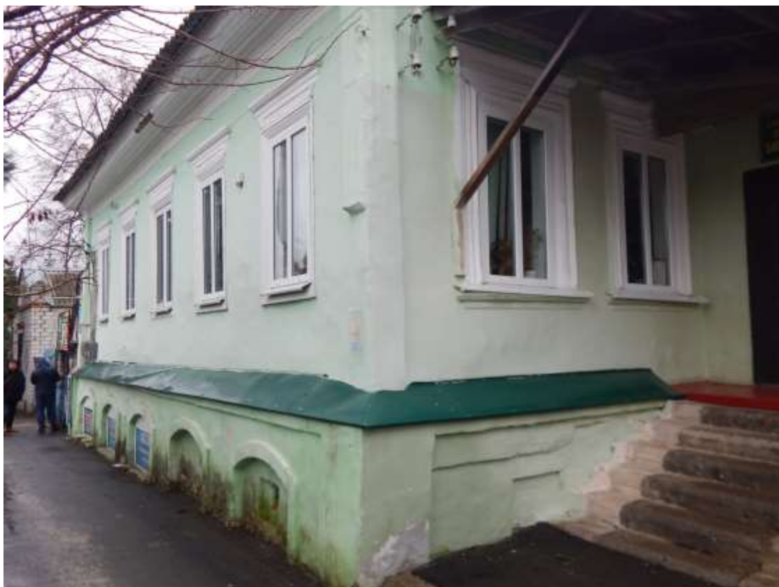
Т.ф. 2. Отдельные элементы декоративного убранства главного фасада Объекта со стороны ул. 1 Мая.
