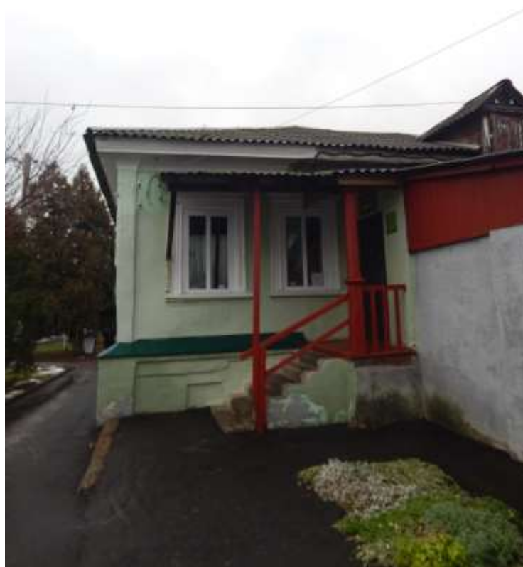
Т.ф. 3. Входное крыльцо в здание со стороны ул. 1 Мая.
