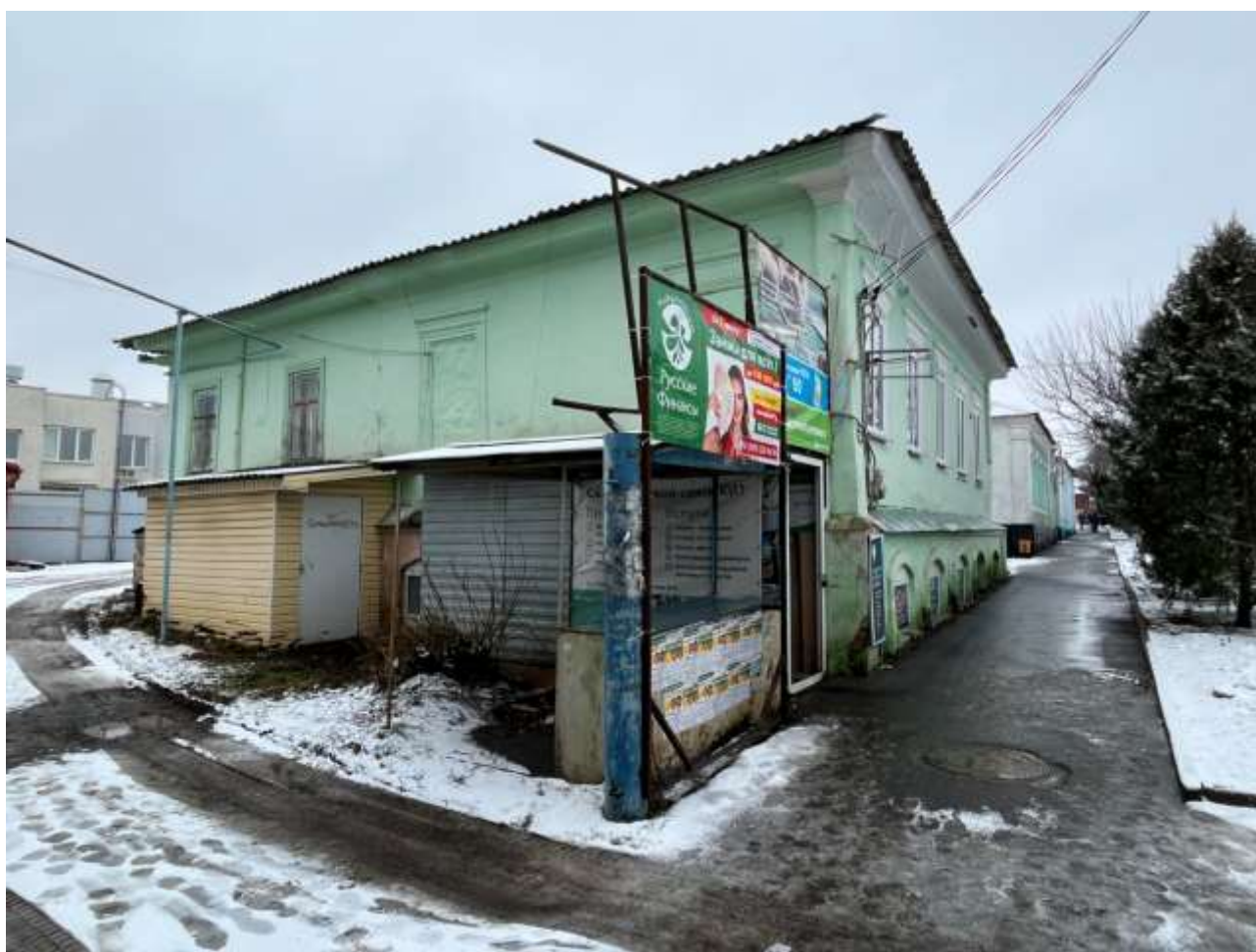
Т.ф. 4. Общий вид бокового фасада Объекта.
