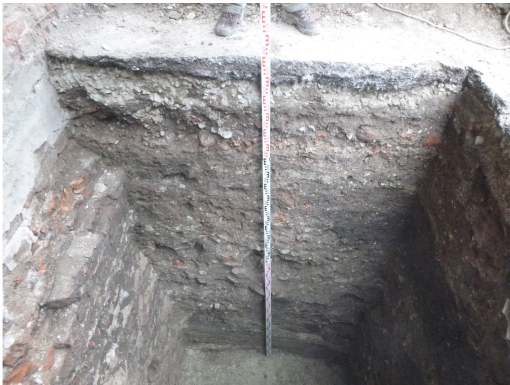
Рис. 29. Проведение работ по приспособлению к современному использованию объекта: «Экспозиционный корпус Курского областного краеведческого музея в объекте культурного наследия регионального значения «Здание мужской классической гимназии, 1836-1842гг.», расположенном по адресу: Курская область, г. Курск, ул. Луначарского, 8, здание литер В». 2022 г. Шурф 2. Юго-восточный борт. Вид с СЗ (разведочные работы С.Н. Головина, 2020 г.).
