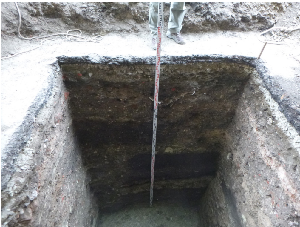
Рис. 32. Проведение работ по приспособлению к современному использованию объекта: «Экспозиционный корпус Курского областного краеведческого музея в объекте культурного наследия регионального значения «Здание мужской классической гимназии, 1836-1842гг.», расположенном по адресу: Курская область, г. Курск, ул. Луначарского, 8, здание литер В». 2022 г. Шурф 2. Юго-западный борт. Вид с СВ. (разведочные работы С.Н. Головина, 2020 г.).
