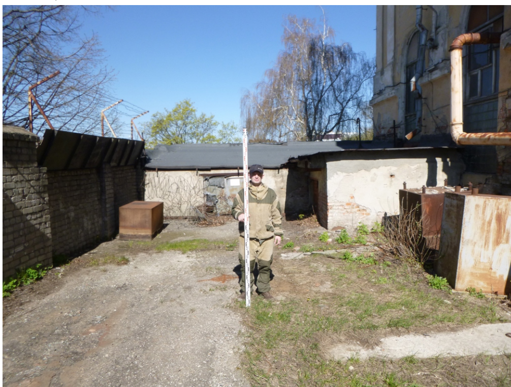
Рис. 15. Проведение работ по приспособлению к современному использованию объекта: «Экспозиционный корпус Курского областного краеведческого музея в объекте культурного наследия регионального значения «Здание мужской классической гимназии, 1836-1842гг.», расположенном по адресу: Курская область, г. Курск, ул. Луначарского, 8, здание литер В». 2022 г. Общий вид участка, точка №3, вид с ЮВ (разведочные работы С.Н. Головина, 2020 г.).
