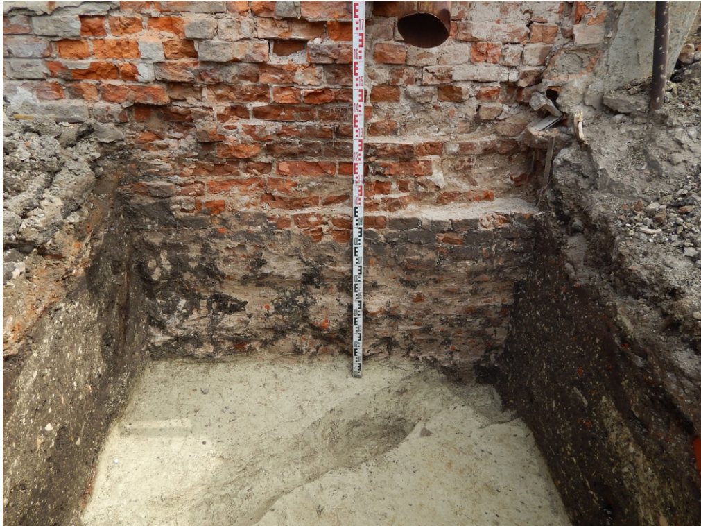
Рис. 27. Проведение работ по приспособлению к современному использованию объекта: «Экспозиционный корпус Курского областного краеведческого музея в объекте культурного наследия регионального значения «Здание мужской классической гимназии, 1836-1842гг.», расположенном по адресу: Курская область, г. Курск, ул. Луначарского, 8, здание литер В». 2022 г. Шурф 1. Северо-восточный борт. Вид с ЮЗ (разведочные работы С.Н. Головина, 2020 г.).
