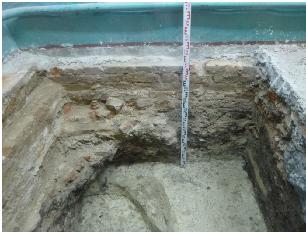
Рис. 45. Проведение работ по приспособлению к современному использованию объекта: «Экспозиционный корпус Курского областного краеведческого музея в объекте культурного наследия регионального значения «Здание мужской классической гимназии, 1836-1842гг.», расположенном по адресу: Курская область, г. Курск, ул. Луначарского, 8, здание литер В». 2022 г. Шурф 3. Юго-восточный борт. Вид с СВ (разведочные работы С.Н. Головина, 2020 г.).
