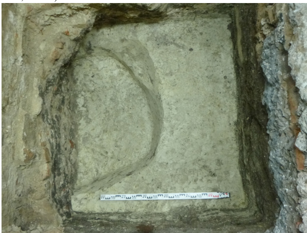
Рис. 39. Проведение работ по приспособлению к современному использованию объекта: «Экспозиционный корпус Курского областного краеведческого музея в объекте культурного наследия регионального значения «Здание мужской классической гимназии, 1836-1842гг.», расположенном по адресу: Курская область, г. Курск, ул. Луначарского, 8, здание литер В». 2022 г. Шурф 3. Пласт 4. Яма 1 после выборки. Вид с СВ. (разведочные работы С.Н. Головина, 2020 г.).
