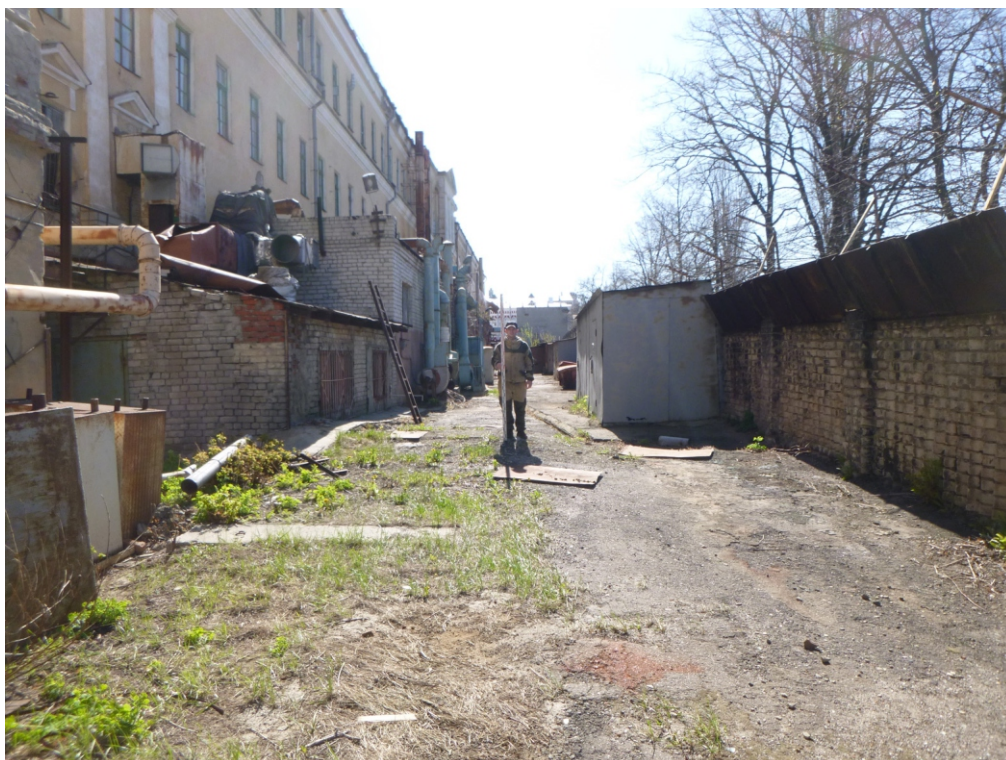
Рис. 16. Проведение работ по приспособлению к современному использованию объекта: «Экспозиционный корпус Курского областного краеведческого музея в объекте культурного наследия регионального значения «Здание мужской классической гимназии, 1836-1842гг.», расположенном по адресу: Курская область, г. Курск, ул. Луначарского, 8, здание литер В». 2022 г. Общий вид участка, точка №3, вид с СЗ (разведочные работы С.Н. Головина, 2020 г.).
