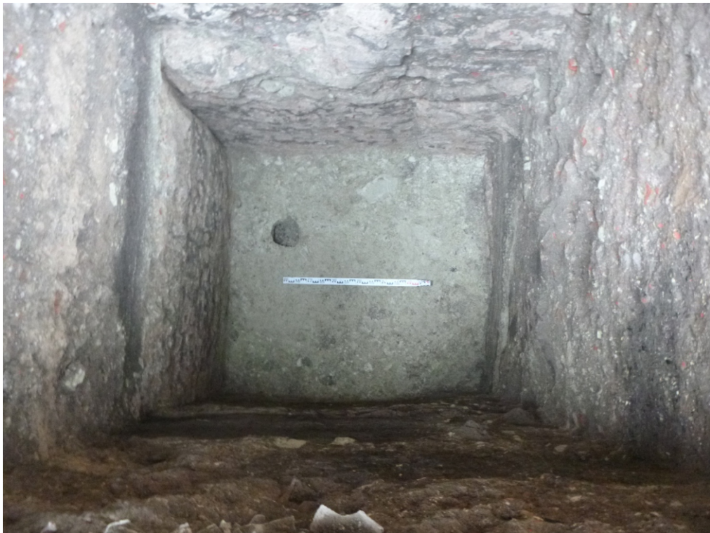
Рис. 28. Проведение работ по приспособлению к современному использованию объекта: «Экспозиционный корпус Курского областного краеведческого музея в объекте культурного наследия регионального значения «Здание мужской классической гимназии, 1836-1842гг.», расположенном по адресу: Курская область, г. Курск, ул. Луначарского, 8, здание литер В». 2022 г. Шурф 2. Пласт 11. Вид с ЮЗ (разведочные работы С.Н. Головина, 2020 г.).
