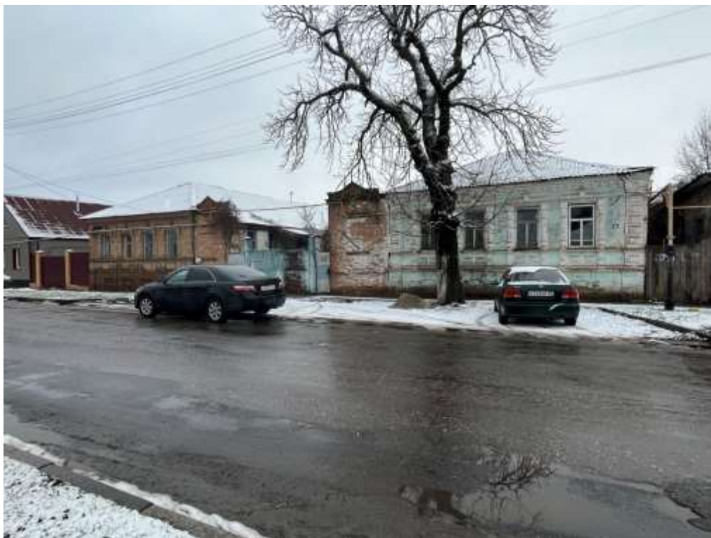
Т.ф. 1. Общий вид Объекта в контексте застройки ул. Комсомольской.
