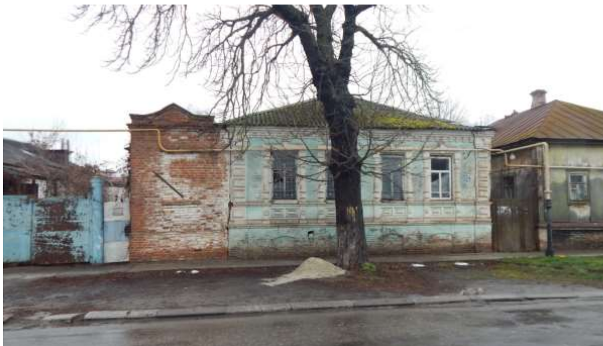
Т.ф. 1. Общий вид Объекта в контексте застройки ул. Комсомольской.
