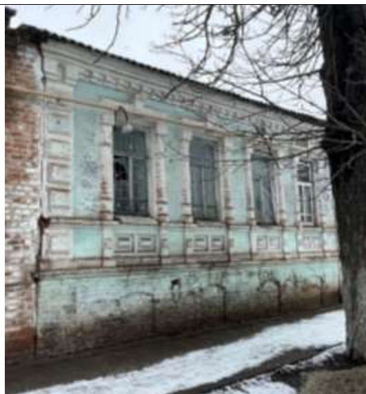
Угловые лопатки, венчающий карниз
