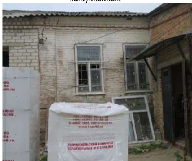
композиция южного фасада. Два окна с клинчатыми перемычками без обрамлений, часть простого карниза
