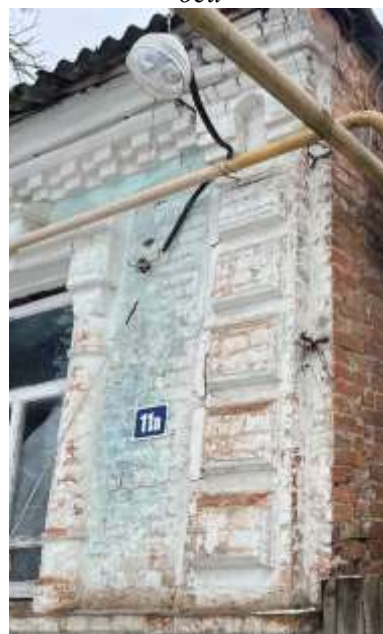
Оформление окных проемов и простенков; широкие пилястры с рустом; верх пилястр с полуциркульной вертикальной нишей
