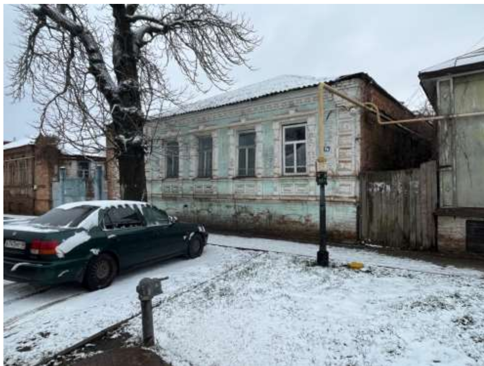
Т.ф. 2. Общий вид Объекта.
