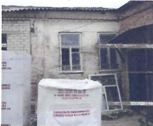
композиция южного фасада. Два окна с кличатыми перемычками без обрамлений, часть простого карниза
