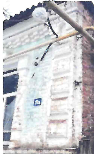
Оформление оконных проемов и простенков; широкие пилеэтры с рустом; верх пилеэстр с полуциркулярной вертикальной нишей
