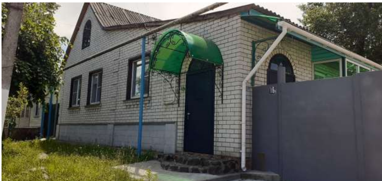
Фотография № 3. Вид с северо-востока на Объект.
