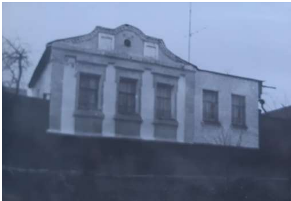
19. Дом по ул. Ленина, 16. Здание Объекта на фотографии в «Проекте охранных зон г. Рыльска Курской обл.» 1990 года.
