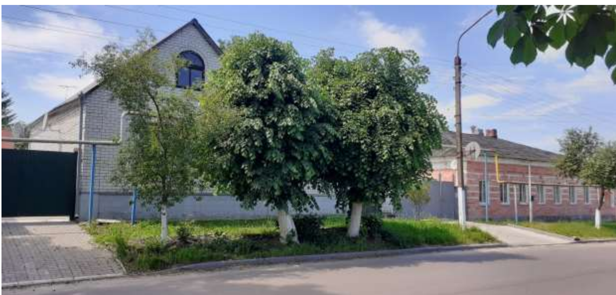
Фотография № 6. Вид с юго-востока на Объект.
