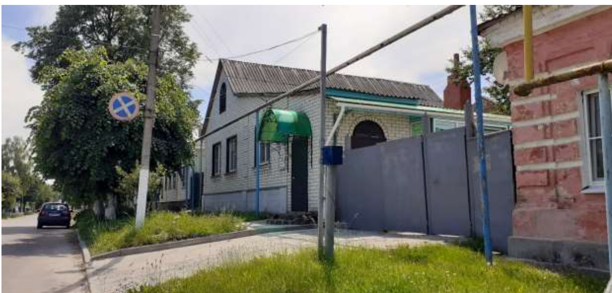
Фотография № 2. Вид с северо-востока на Объект.
