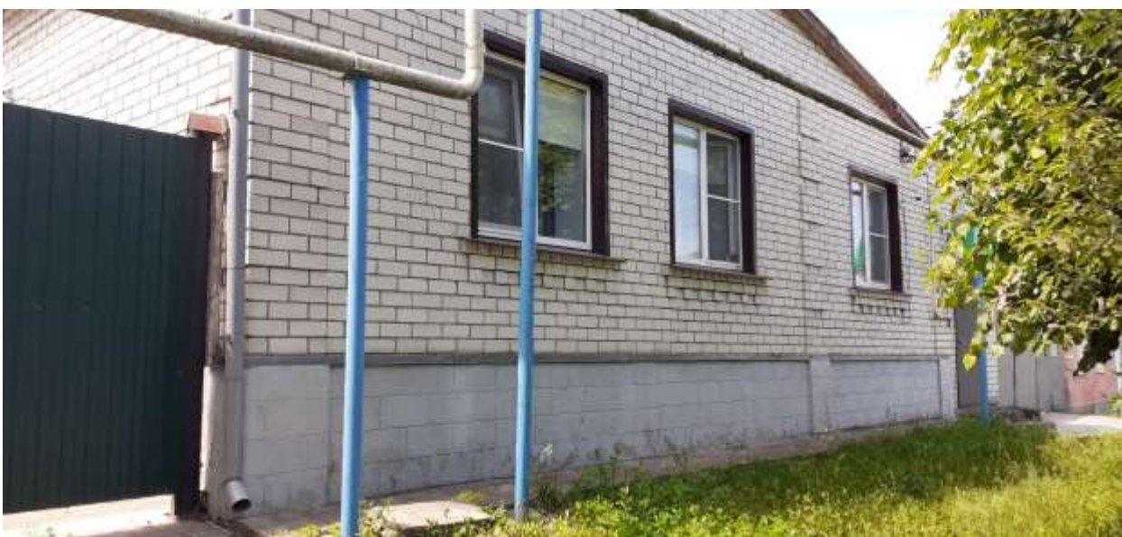
Фотография № 10. Вид с северо-запада на Объект.
