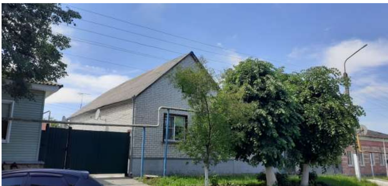
Фотография № 8. Вид с юго-востока на Объект.
