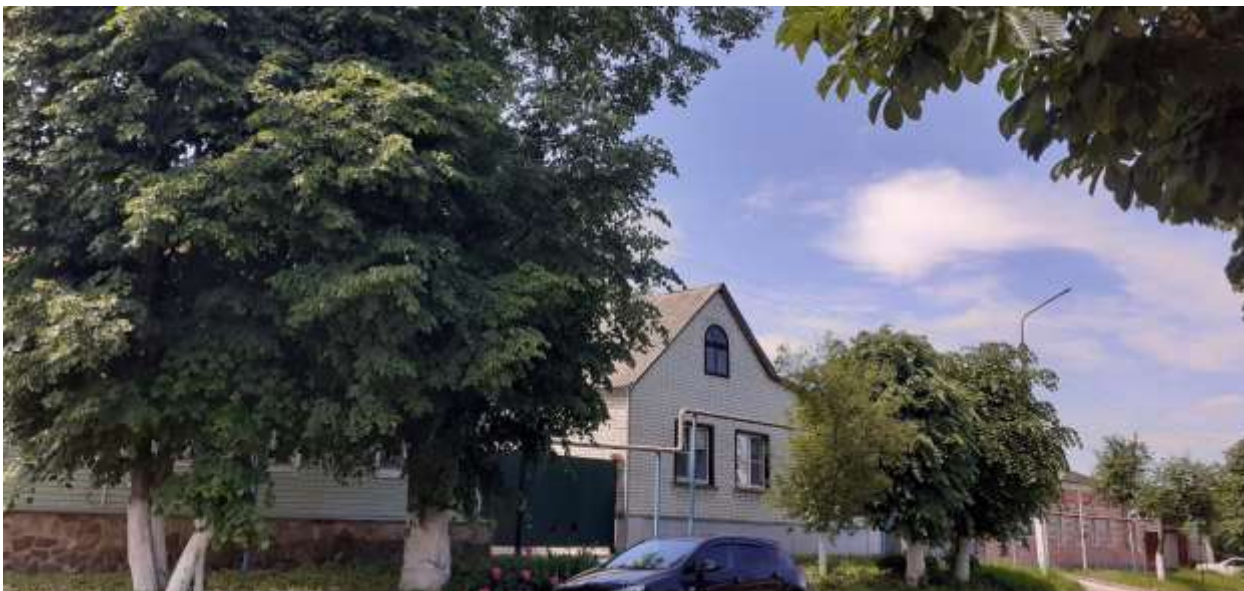
Фотография № 9. Вид с юго-востока на Объект.
