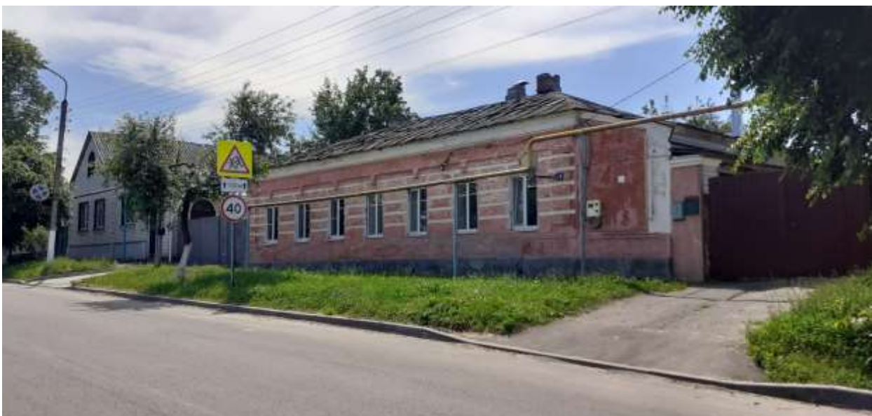
Фотография № 1. Вид с северо-востока на Объект.
