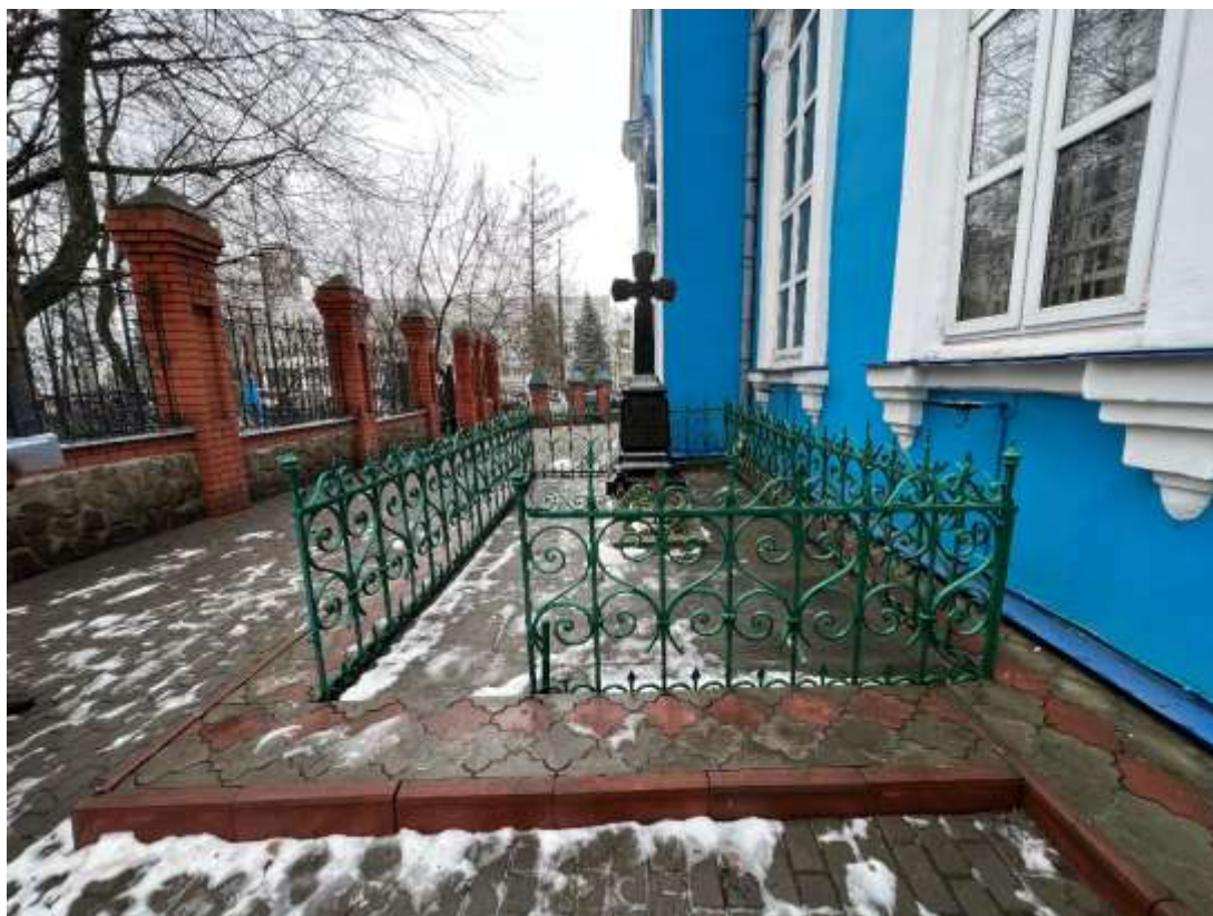
Фотография № 1. Вид с юго-запада на Объект.
