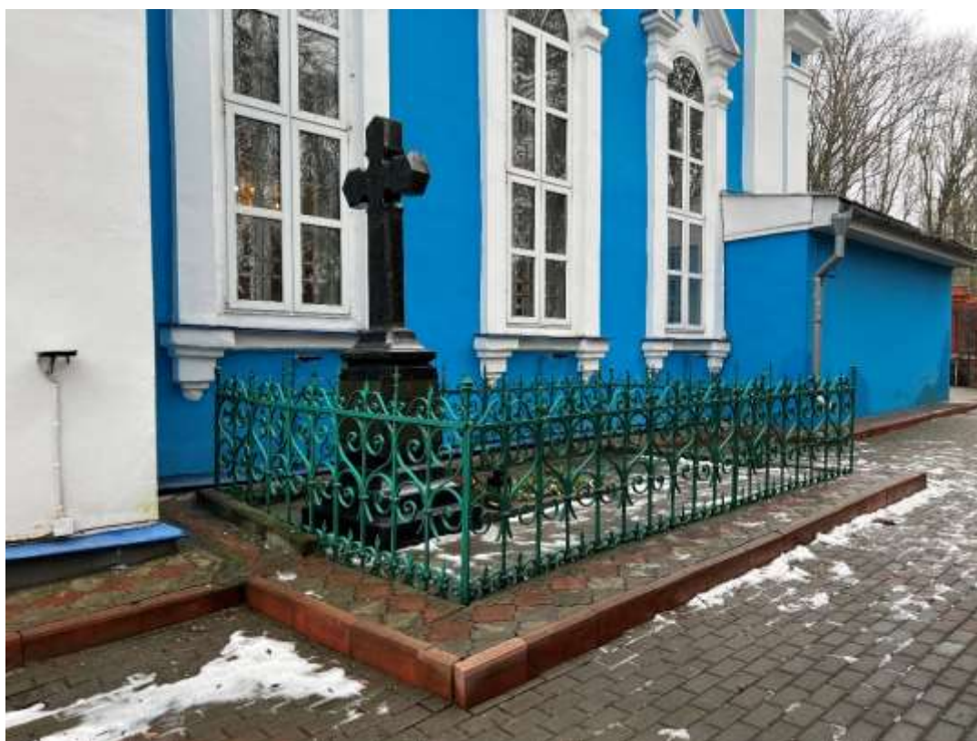
Фотография № 6. Вид с севера на Объект.
