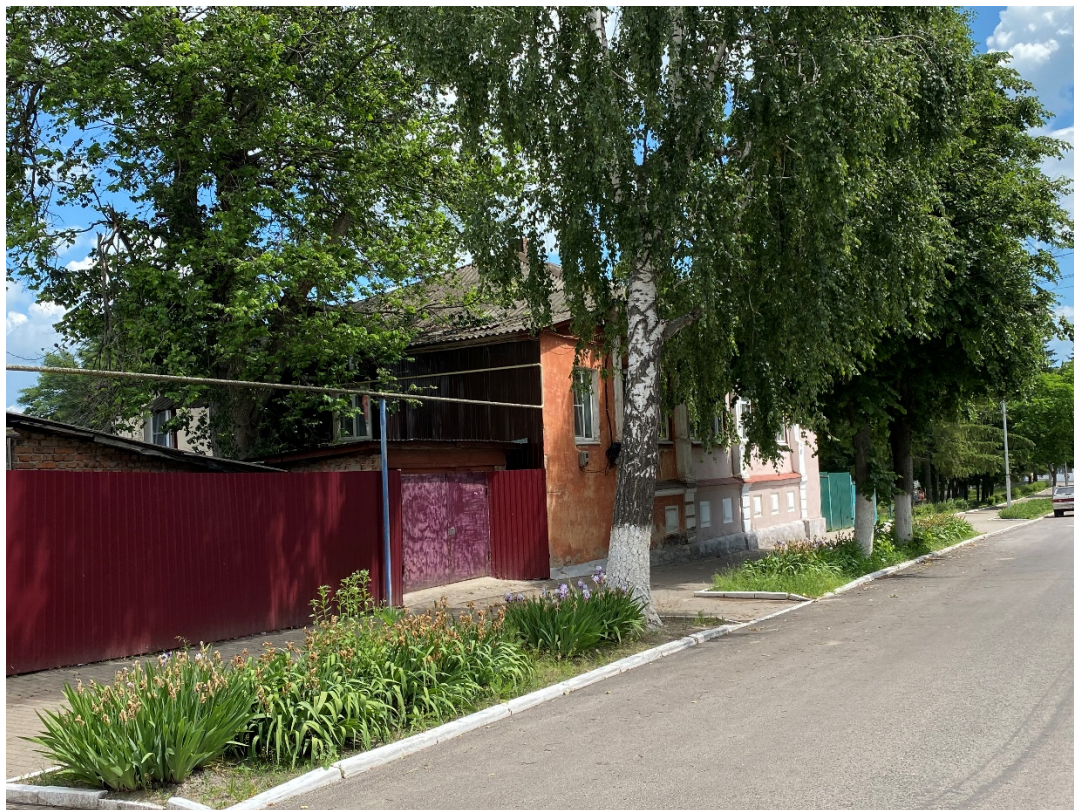
Фотография № 9. Вид с юго-запада на Объект.
