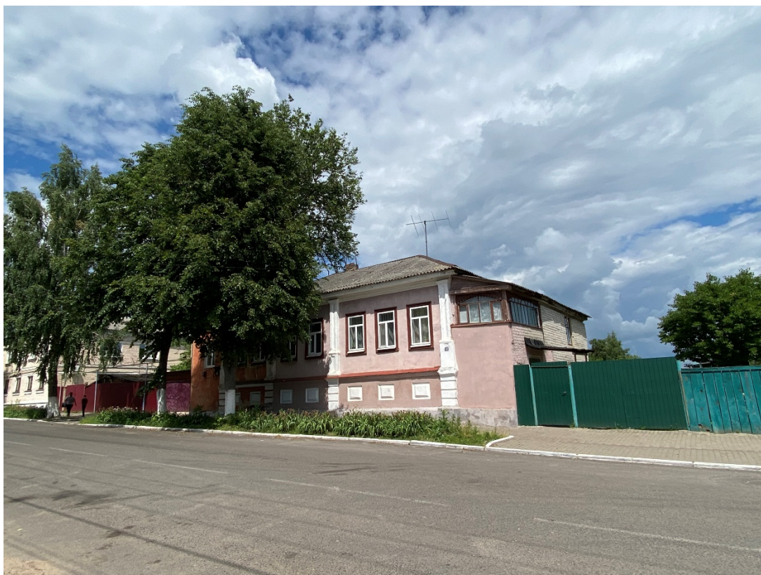
Фотография № 6. Вид с юго-востока на Объект.
