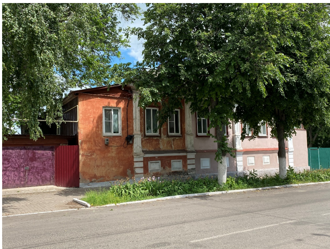
Фотография № 8. Вид с юго-запада на Объект.
