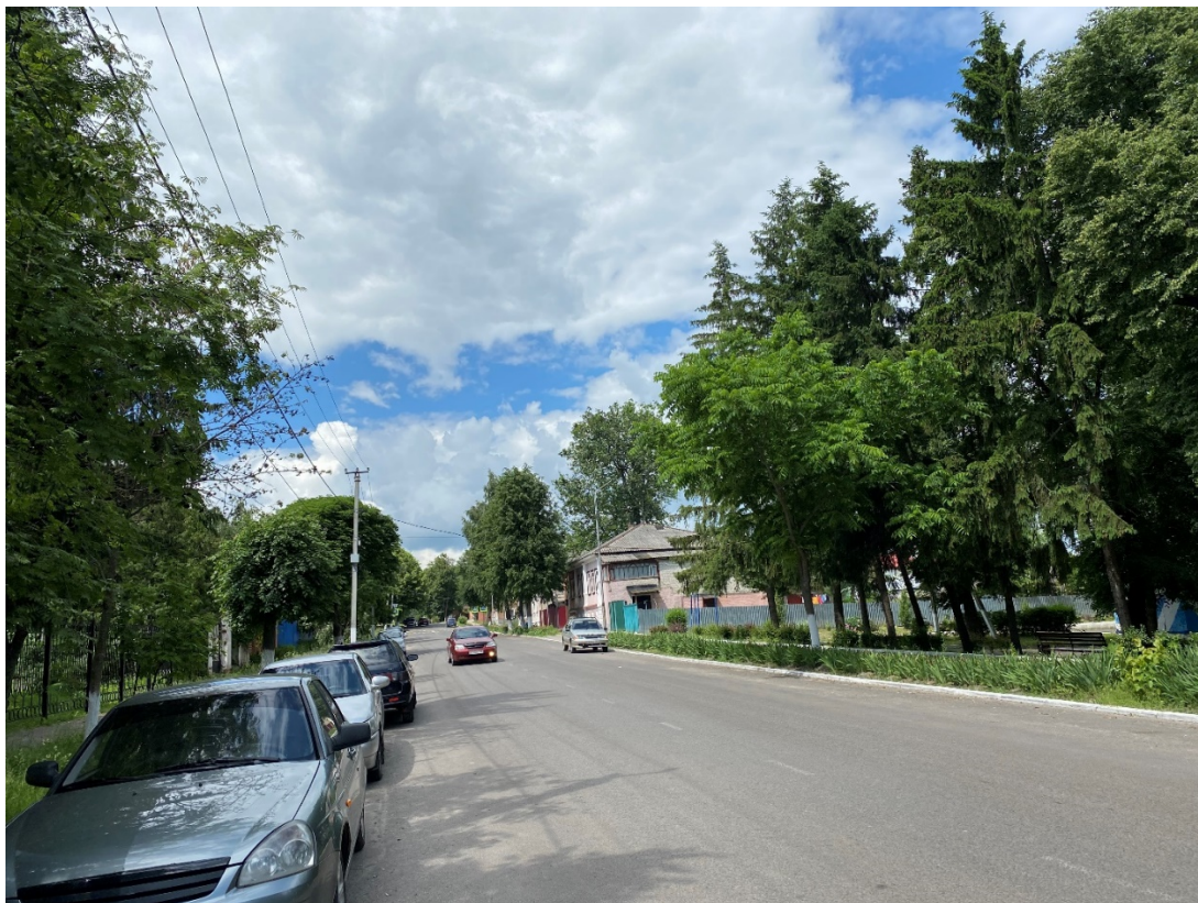
Фотография № 1. Вид с юго-востока на Объект.
