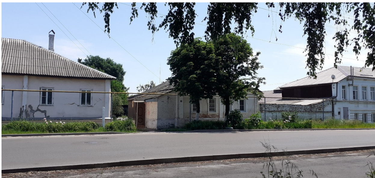
Фотография № 9. Вид с северо-запада на Объект.
