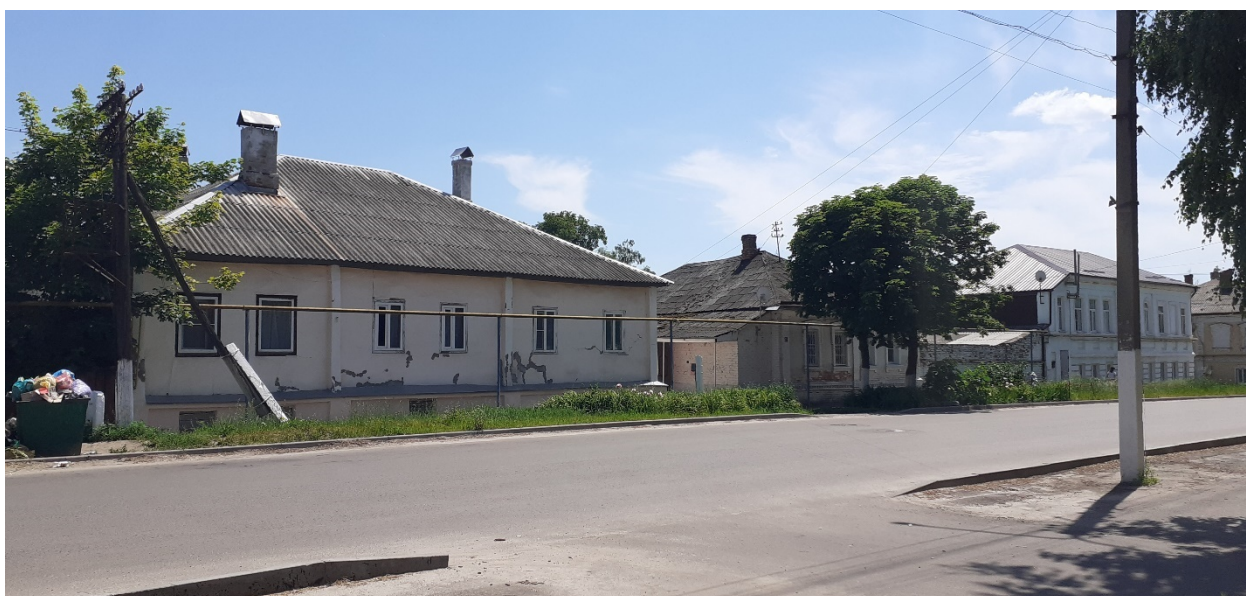
Фотография № 10. Вид с северо-запада на Объект.
