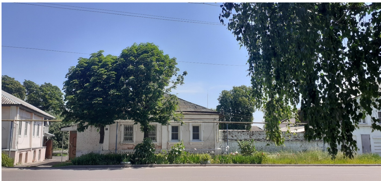
Фотография № 7. Вид с северо-запада на Объект.
