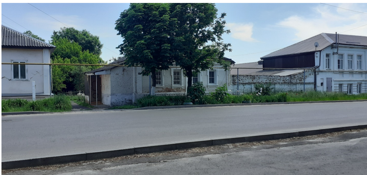
Фотография № 8. Вид с северо-запада на Объект.
