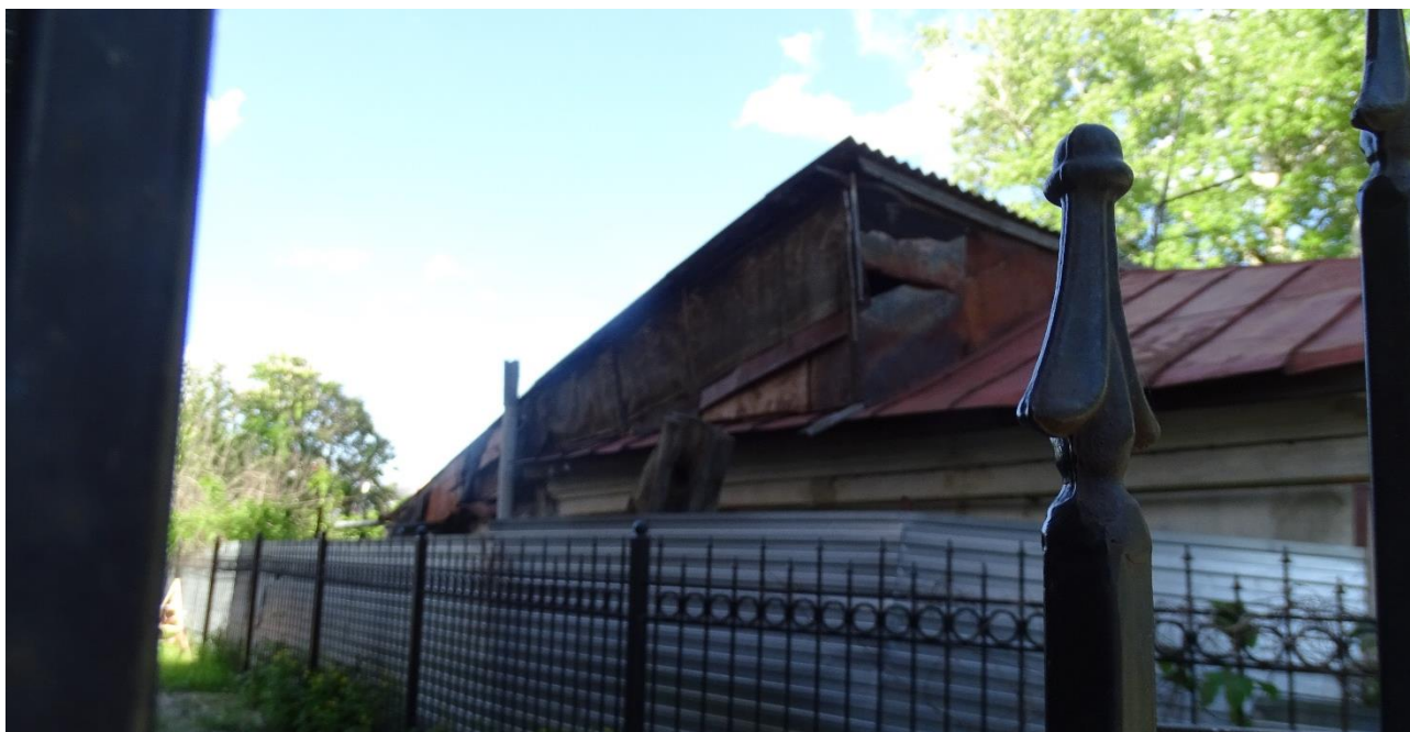
Фото 7. Кровля над старой частью здания
