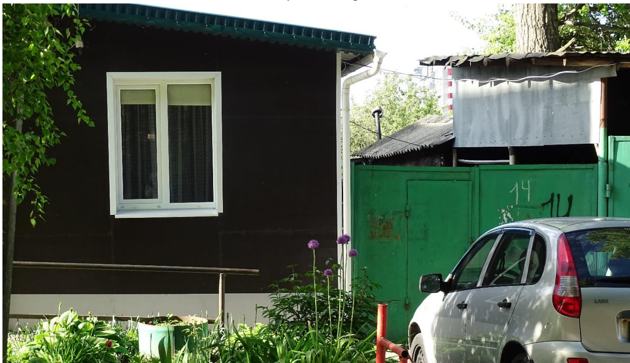
Фото 4. Пристрой к фасаду с восточной стороны.
