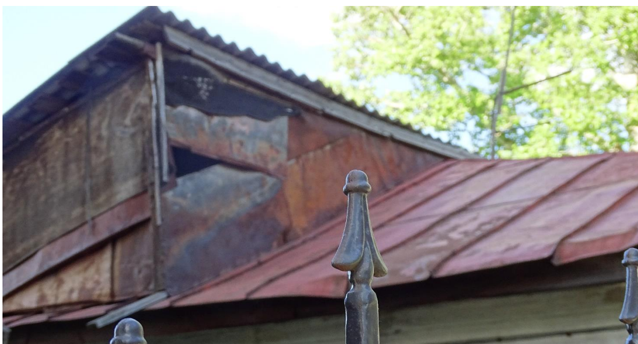
Фото 8. Кровля над старой частью здания. Фрагмент.
