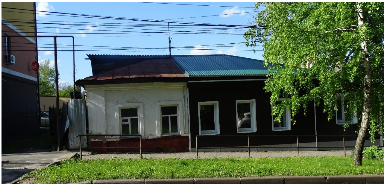
Фото 5. Комбинированная кровля Объекта
