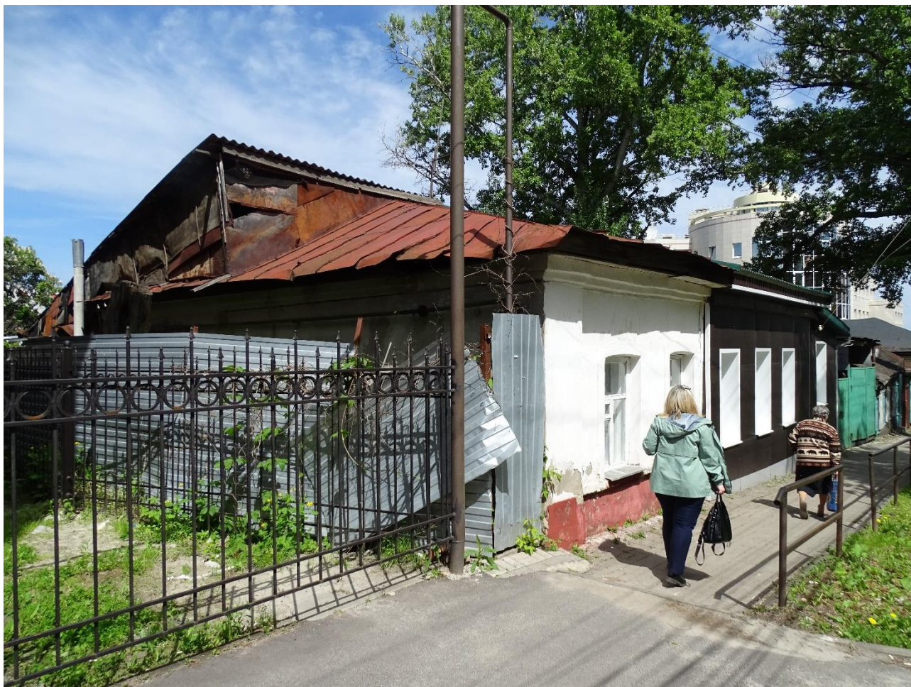
Фото 6. Общий вид кровли над старой частью.
