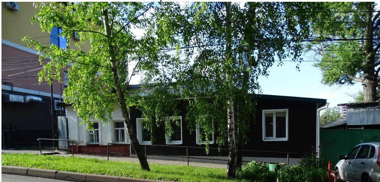
Фото 1. Общий вид Объекта по ул. Мирная.
