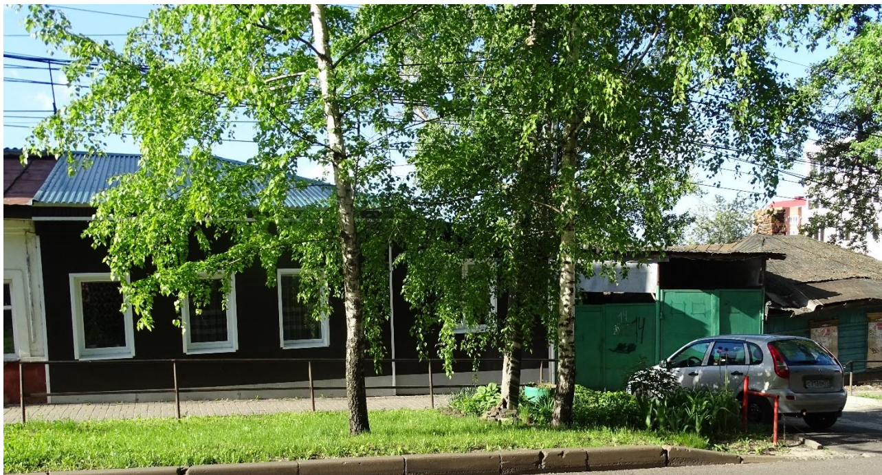
Фото 9. Покрытие крыши над обновленной частью дома.
