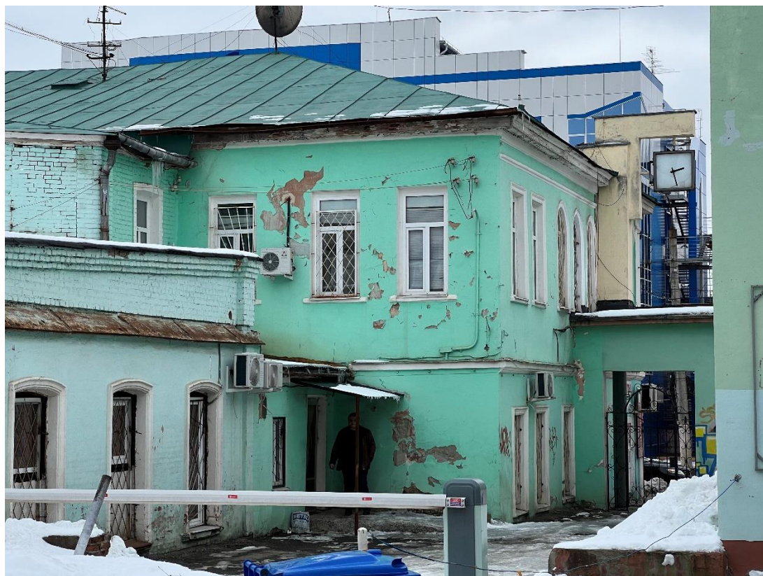
Фотография № 13. Вид с северо-запада на Объект.
