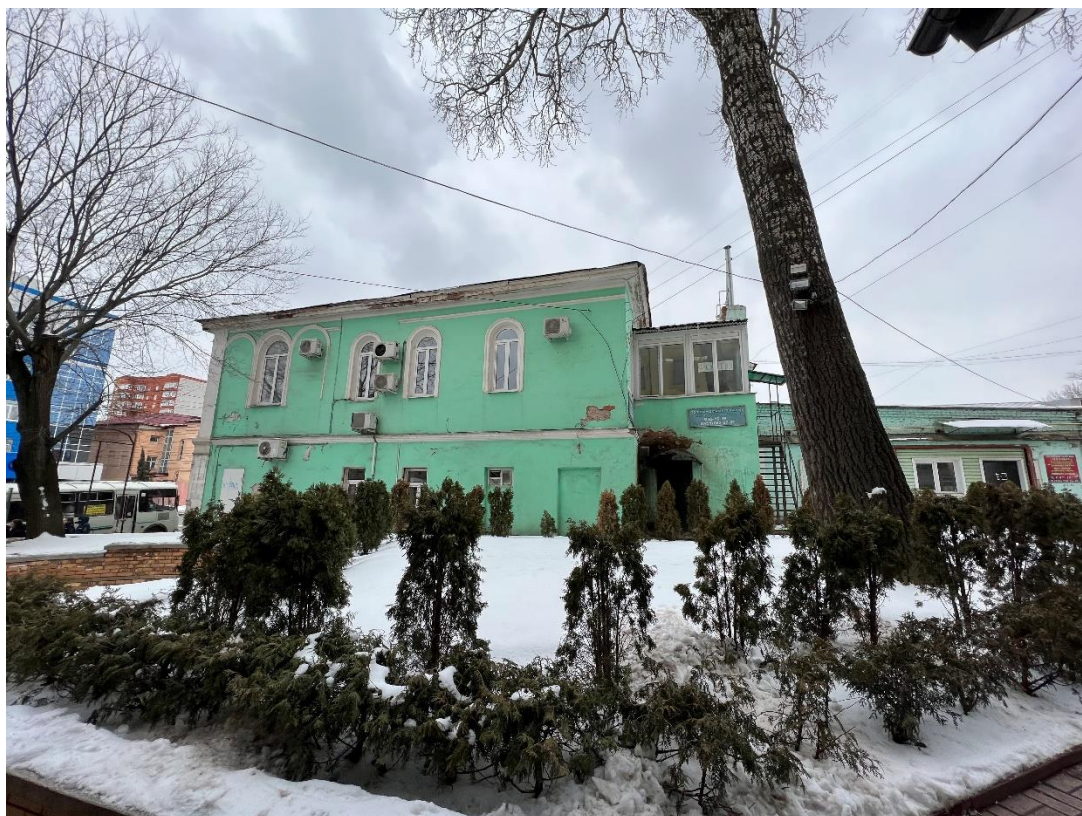
Фотография № 9. Вид с северо-востока на Объект.
