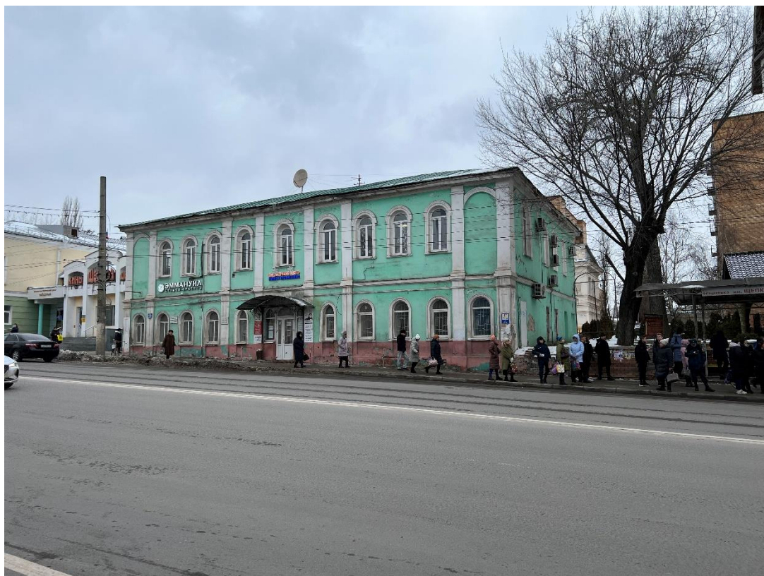
Фотография № 7. Вид с юго-востока на Объект.
