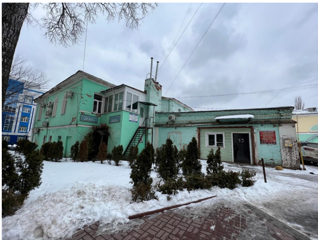
Фотография № 10. Вид с северо-востока на Объект.
