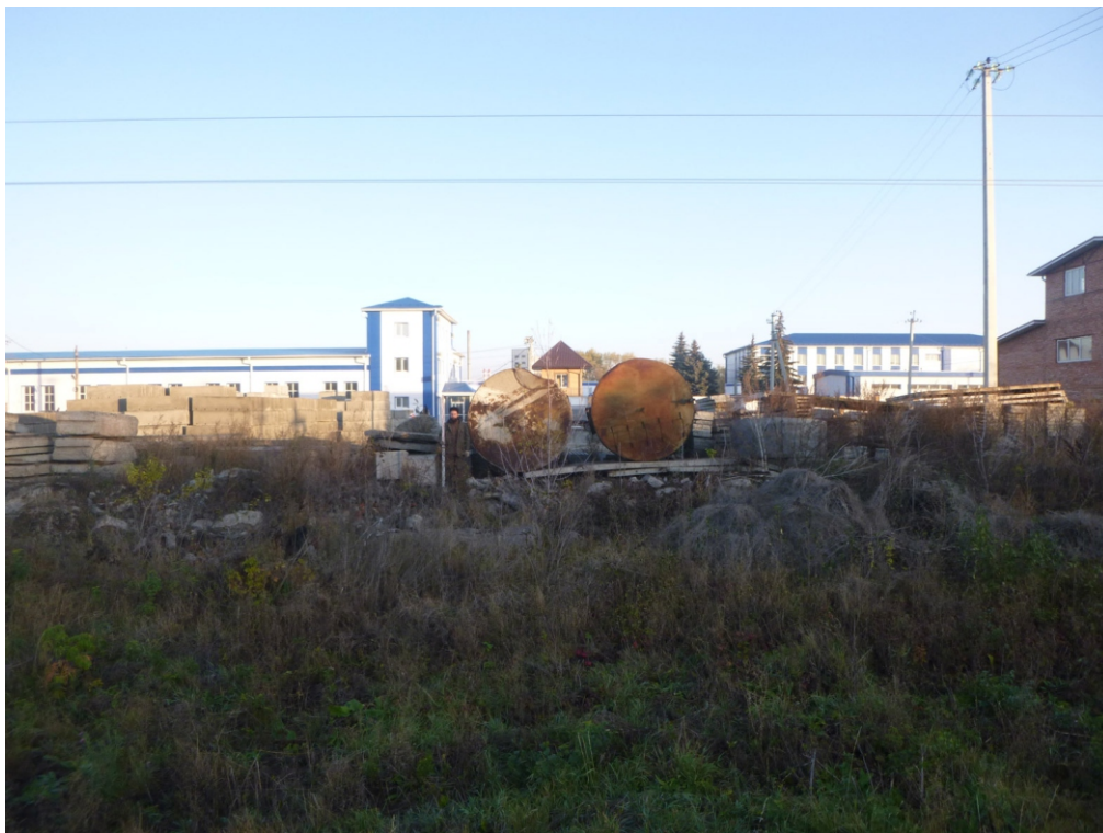
Илл. 18. КРО-2020. Г. Курск. Ул. Привокзальная. Общий вид участка обследования. Точка № 5. Снимок № 1. Вид с ЮЮВ.
