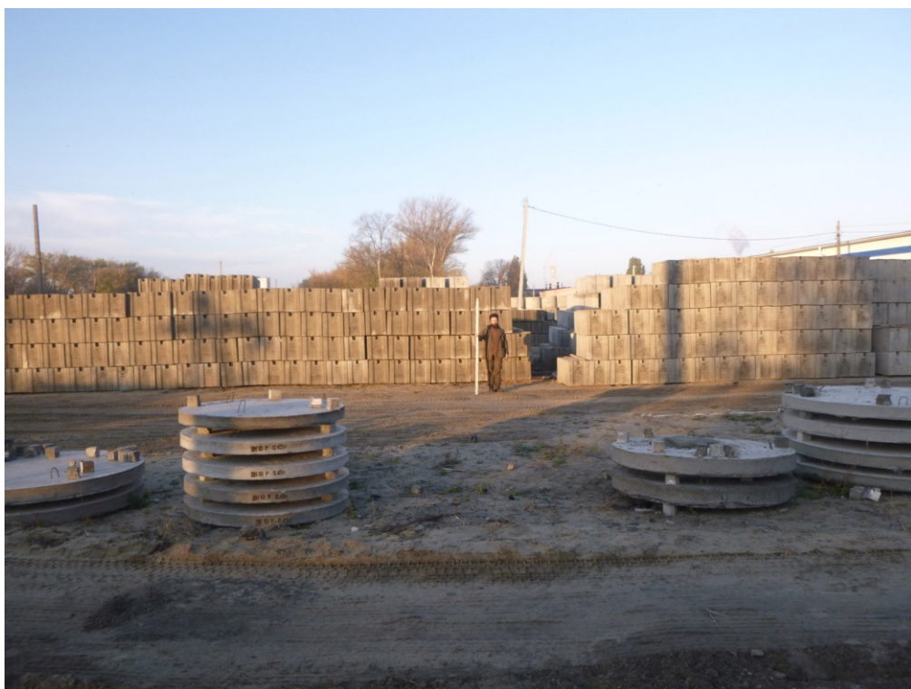
Илл. 16. КРО-2020. Г. Курск. Ул. Привокзальная. Общий вид участка обследования. Точка № 3. Снимок № 4. Вид с ВСВ.
